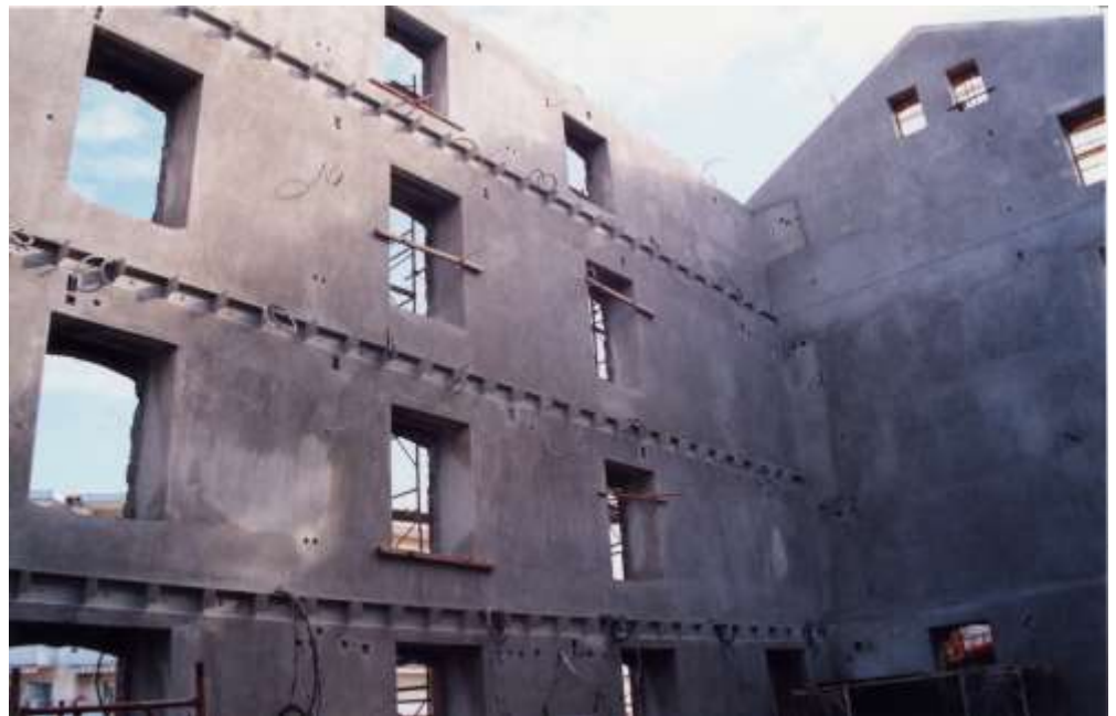
Εργασίες ενίσχυσης των τοιχοποιιών (ενέματα, gunite)
