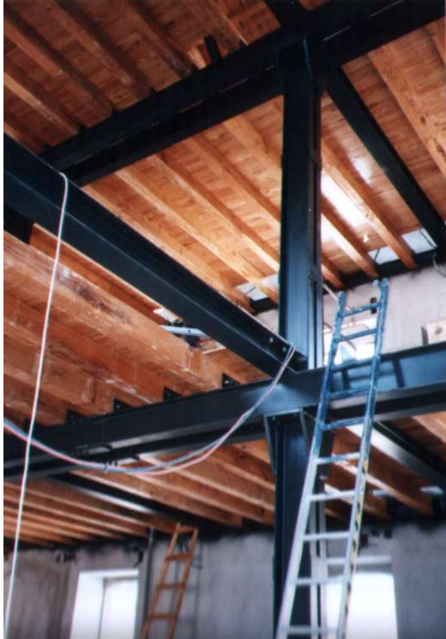
Ανακατασκευή μεταλλικού σκελετού δαπέδων. Εμφανής τοποθέτηση Η/Μ εγκαταστάσεων
