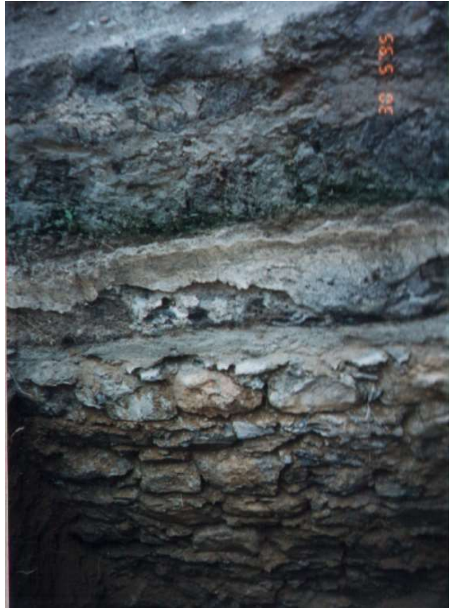
Ισχυρή βαθιά θεμελίωση από σιδηρόπετρα
