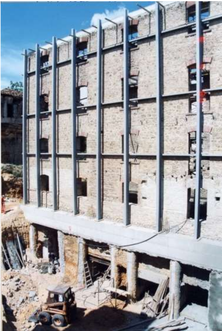
Διάνοιξη ενός υπογείου στο εσωτερικό του μύλου
