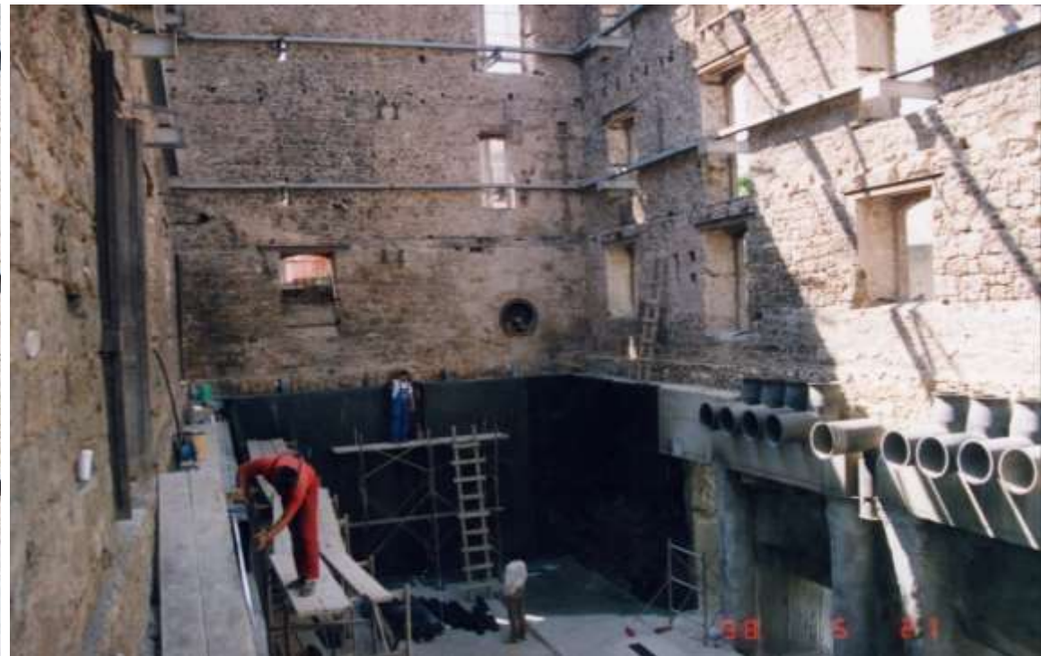
Διάνοιξη ενός υπογείου στο εσωτερικό του μύλου
