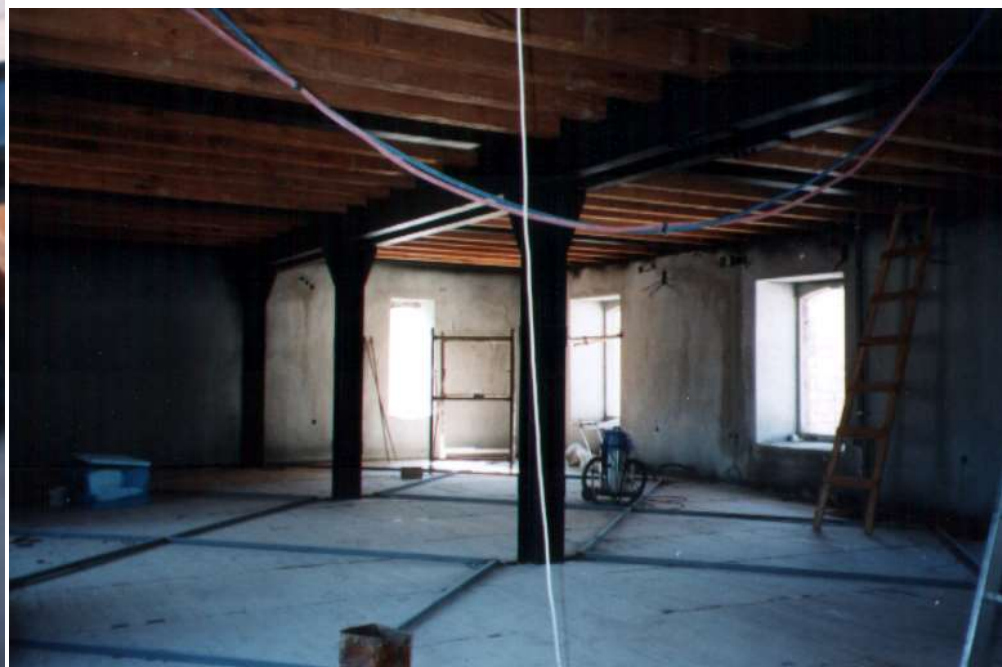
Ανακατασκευή μεταλλικού σκελετού δαπέδων. Εμφανής τοποθέτηση Η/Μ εγκαταστάσεων
