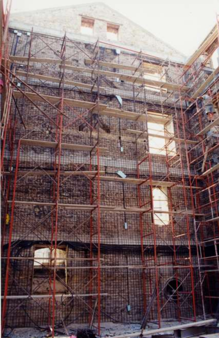
Εργασίες ενίσχυσης των τοιχοποιιών (ενέματα, gunite)
