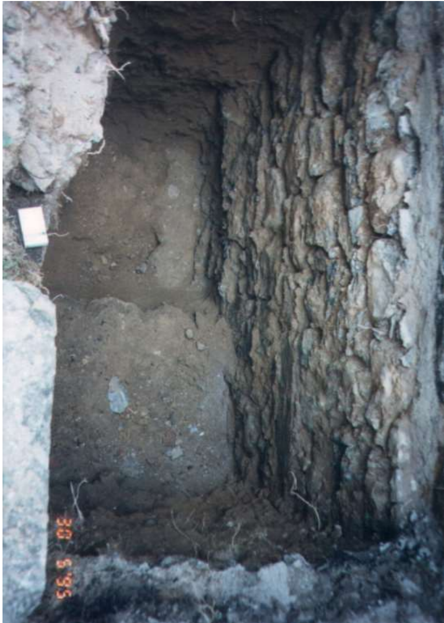
Ισχυρή βαθιά θεμελίωση από σιδηρόπετρα
