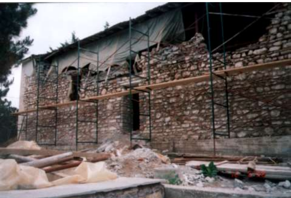
Βόρεια όψη. Αρμολογήματα ανακτήσεις
