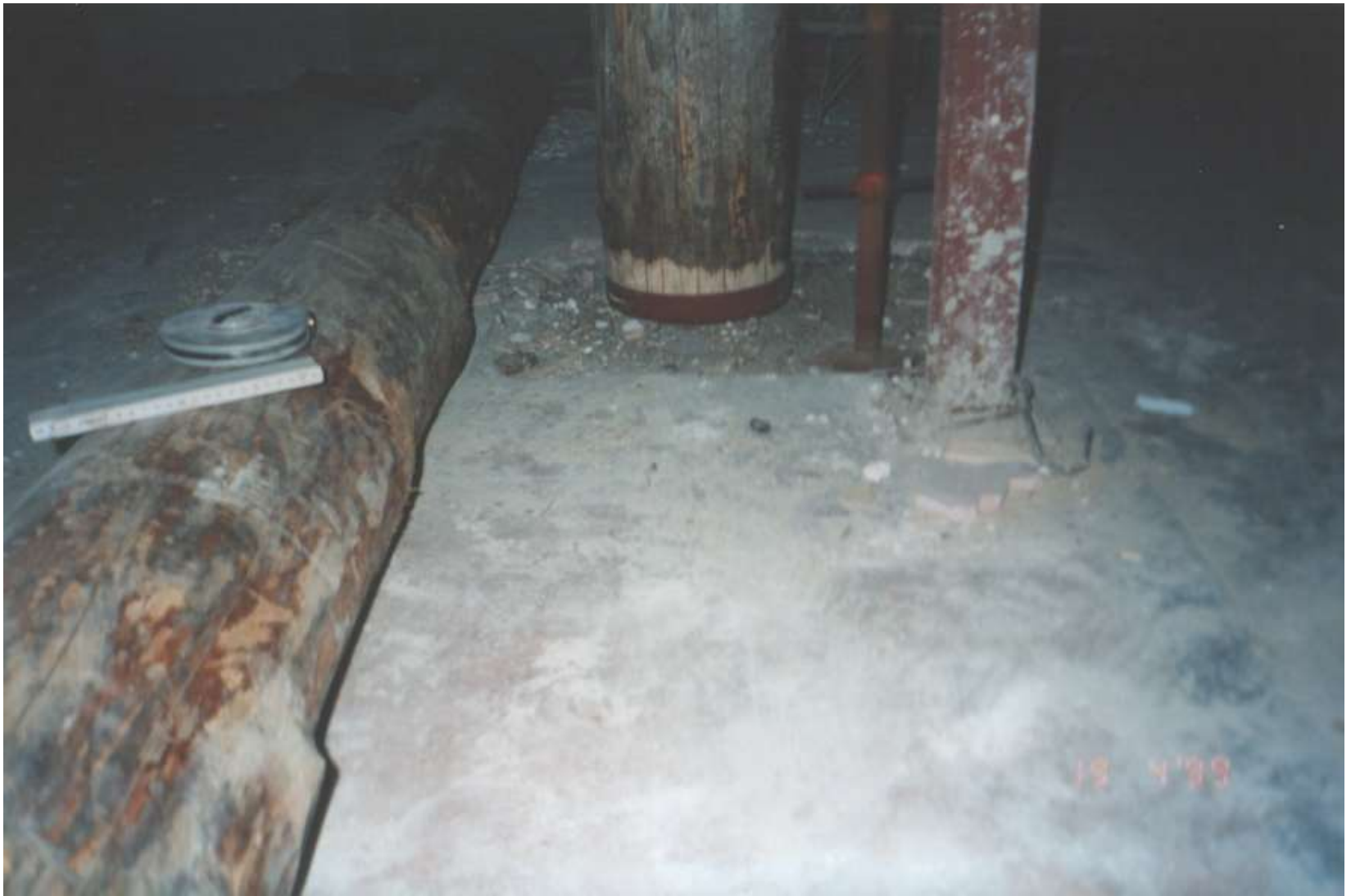
Αντικατάσταση ή εξυγίανση ξύλινων κιόνων
