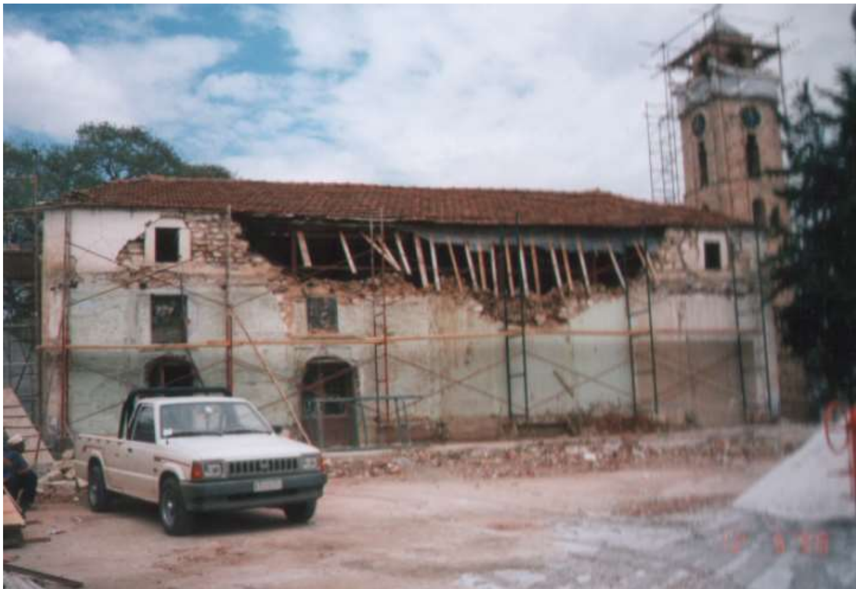
Καθαίρεση της νότιας, μεταγενέστερης στοάς από οπλισμένο σκυρόδεμα
