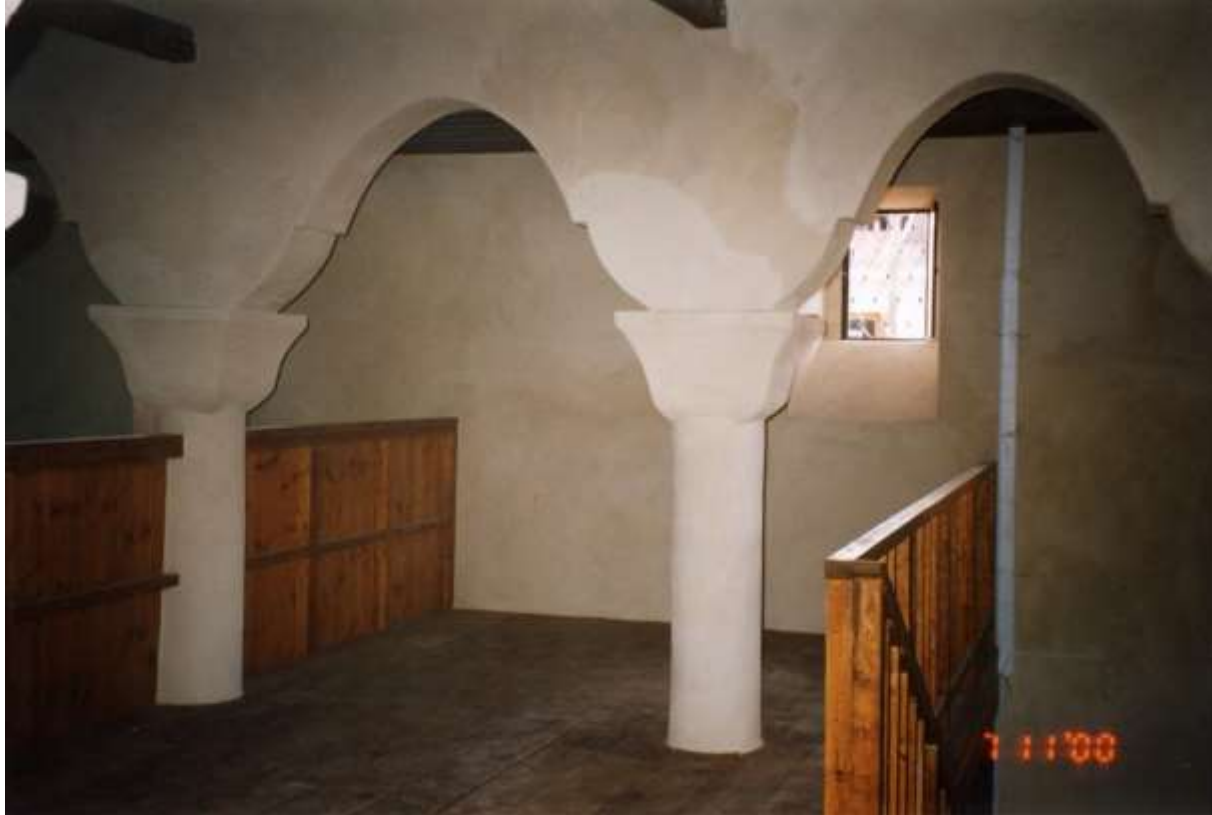
Ανακατασκευή ξύλινου υπερώου
