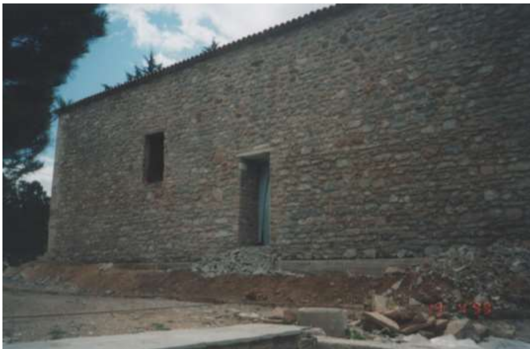
Διάνοιξη πόρτας επικοινωνίας στο βόρειο τοίχο
