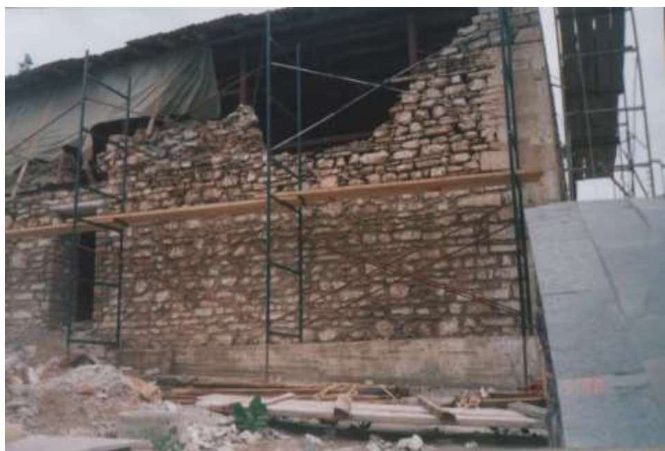
Βόρεια όψη. Αρμολογήματα ανακτήσεις
