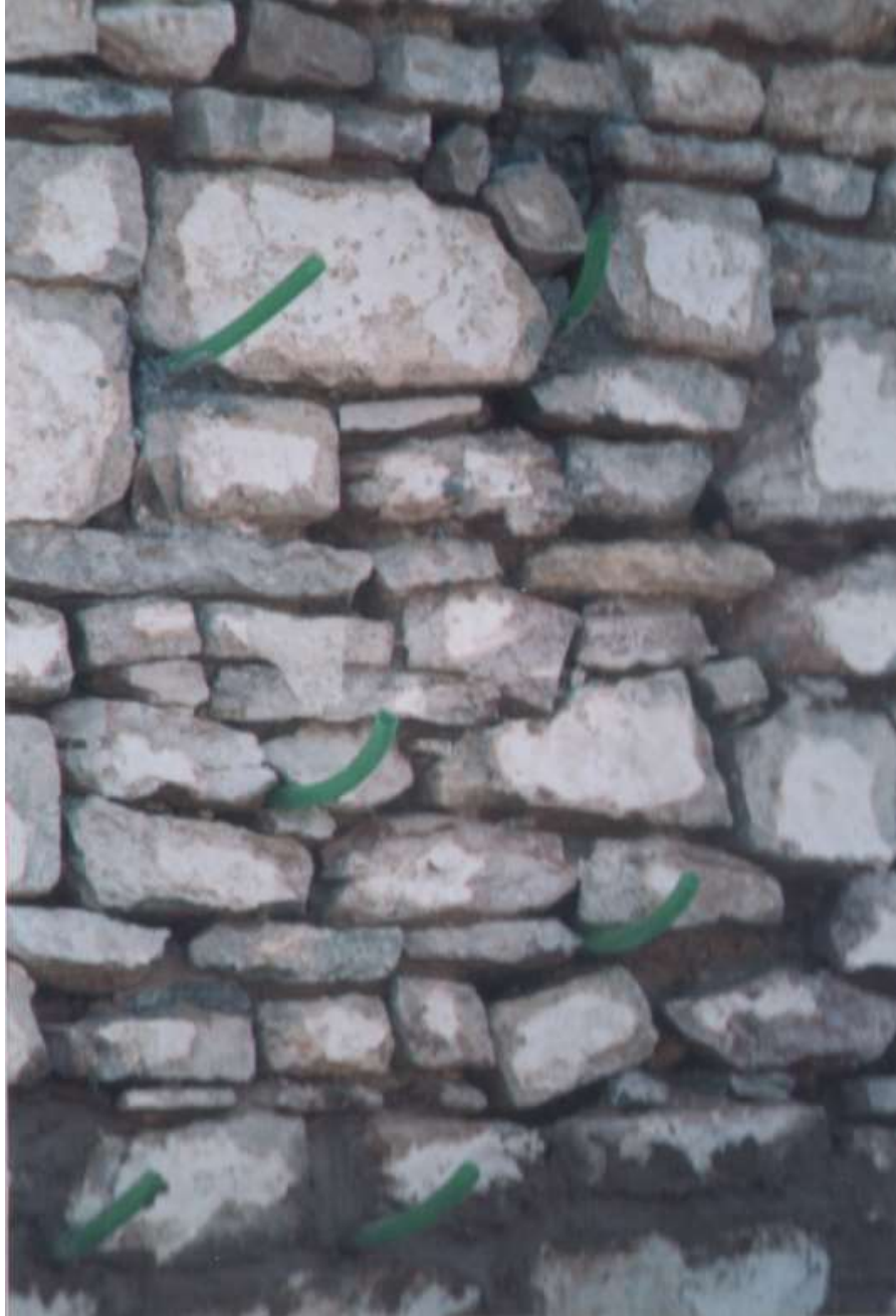
Καθαρισμοί των αρμών σε βάθος, τοποθέτηση σωλήνων ενεμάτων, αρμολόγηση
