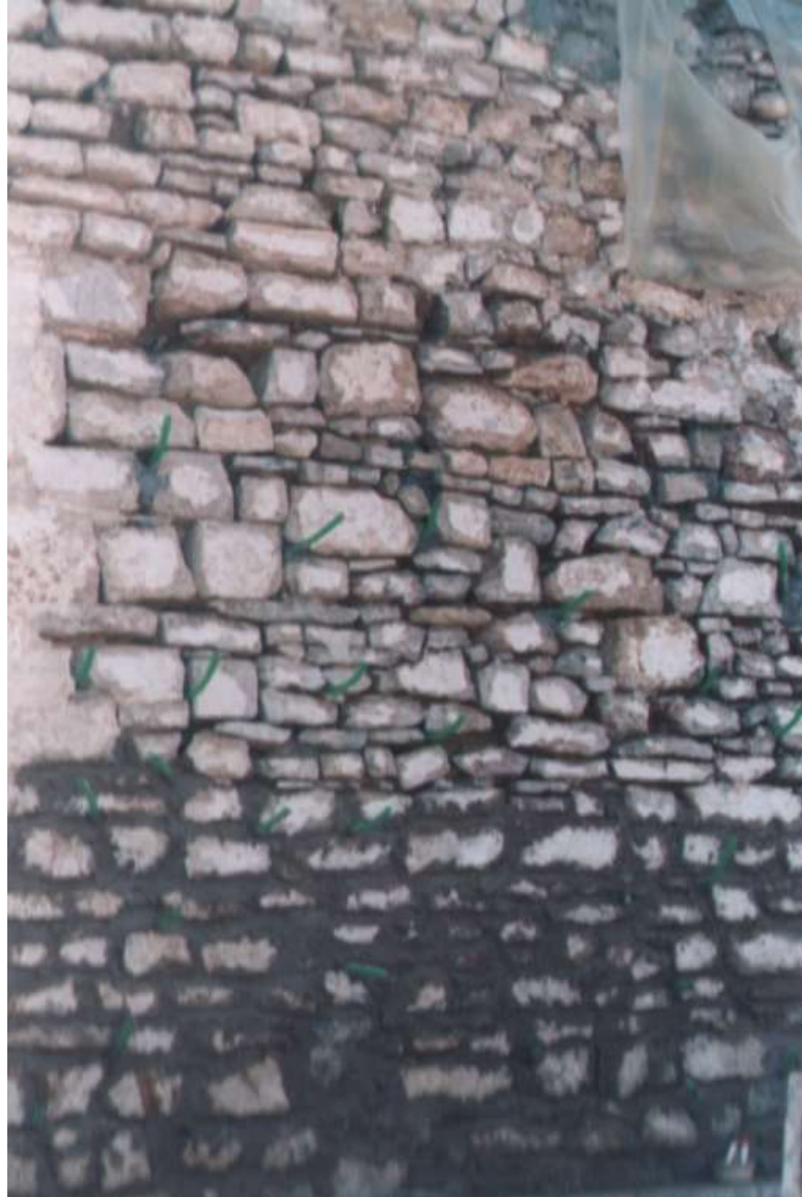
Καθαρισμοί των αρμών σε βάθος, τοποθέτηση σωλήνων ενεμάτων, αρμολόγηση
