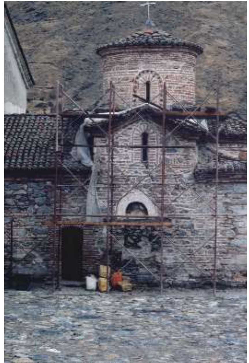
Νότια όψη. Καθαίρεση επιχρισμάτων και αρμολόγηση
