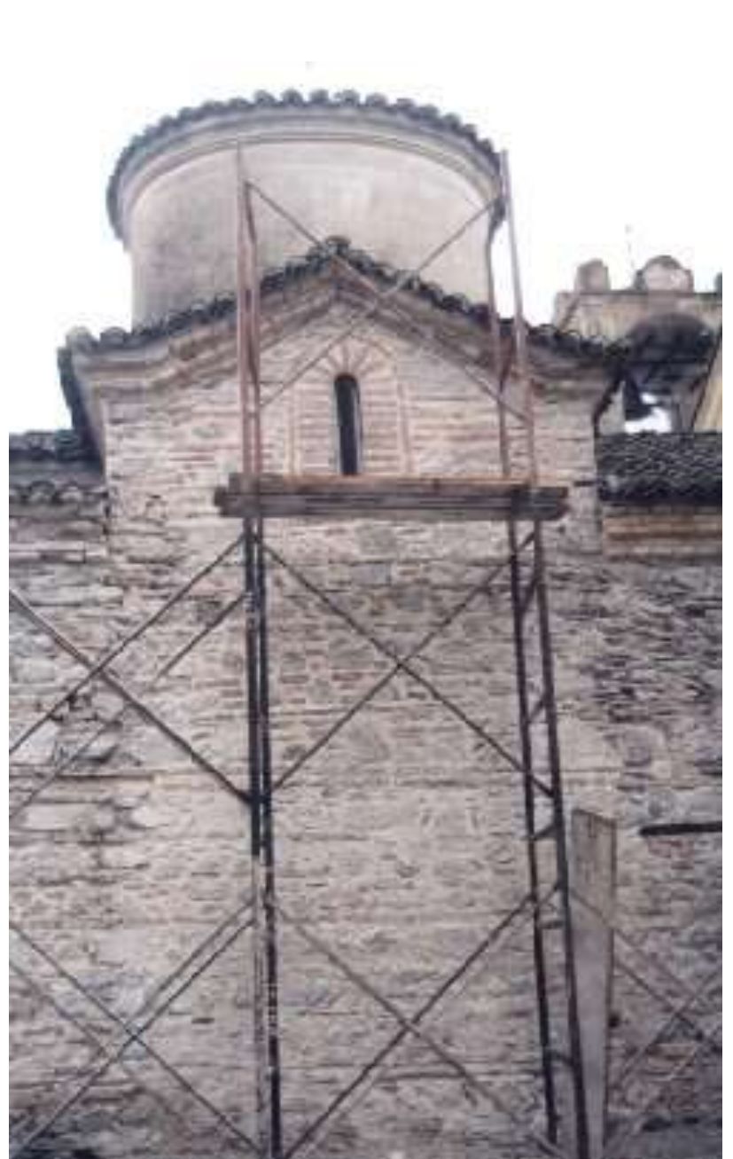
Βόρεια όψη. Καθαίρεση επιχρισμάτων και αρμολόγηση
