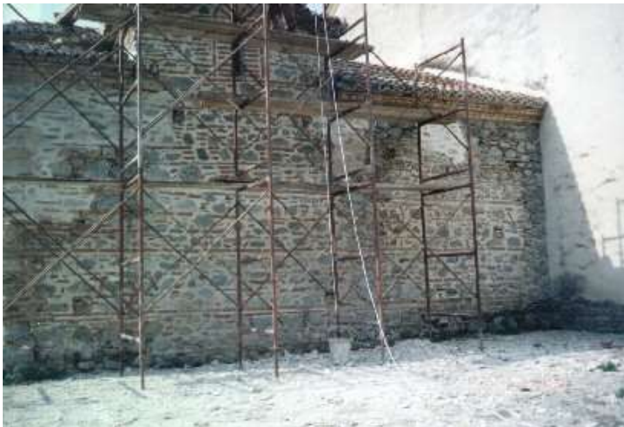
Βόρεια όψη. Καθαίρεση επιχρισμάτων και αρμολόγηση
