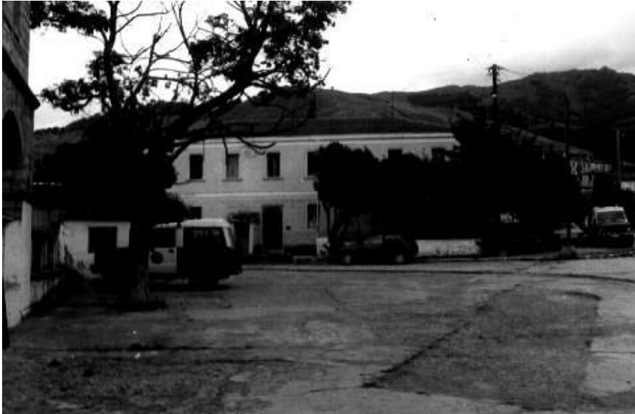
Το τρίγωνο στάθμευσης αυτοκινήτων σε επαφή με την εξωτερική παρειά της περίφραξης
