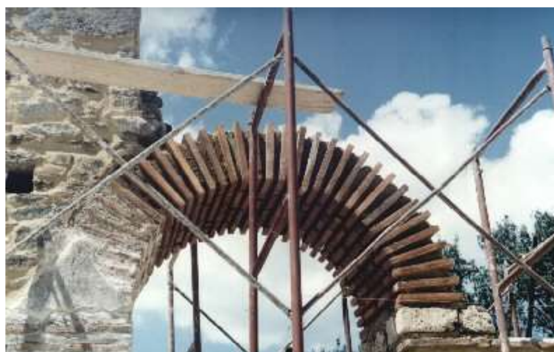
Ανακατασκευή τόξων βόρειας πεσσοστοιχίας
