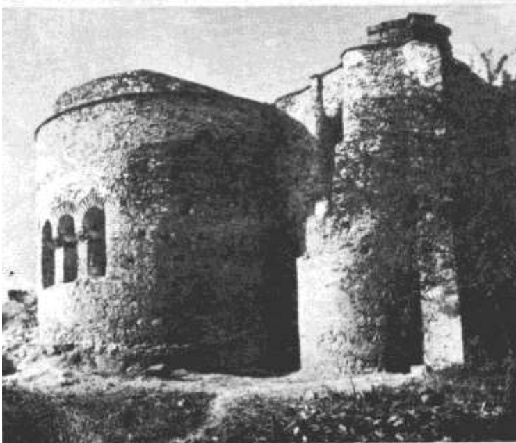
"Αποψη της ΒΑ εξωτερικής πλευράς της βασιλικής του Ἁγίου Ἀχιλλείου. 1, πρὶ, καὶ 2, μετὰ τὶς ἐργασίες καθαρισμοῦ.
