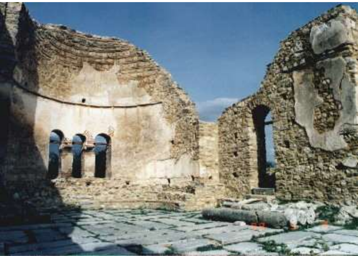
Αρμολογήματα λιθοδομών και στεφάνωμα επιχρισμάτων ΝΑ γωνία ιερού μετά τις εργασίες
