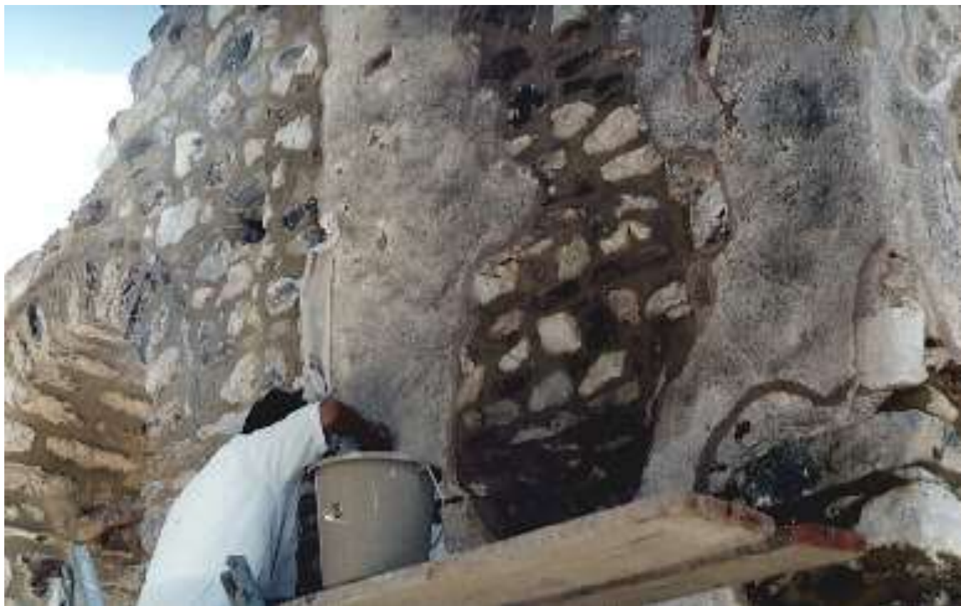
Αρμολογήματα λιθοδομών και στεφάνωμα επιχρισμάτων ΝΑ γωνία ιερού μετά τις εργασίες
