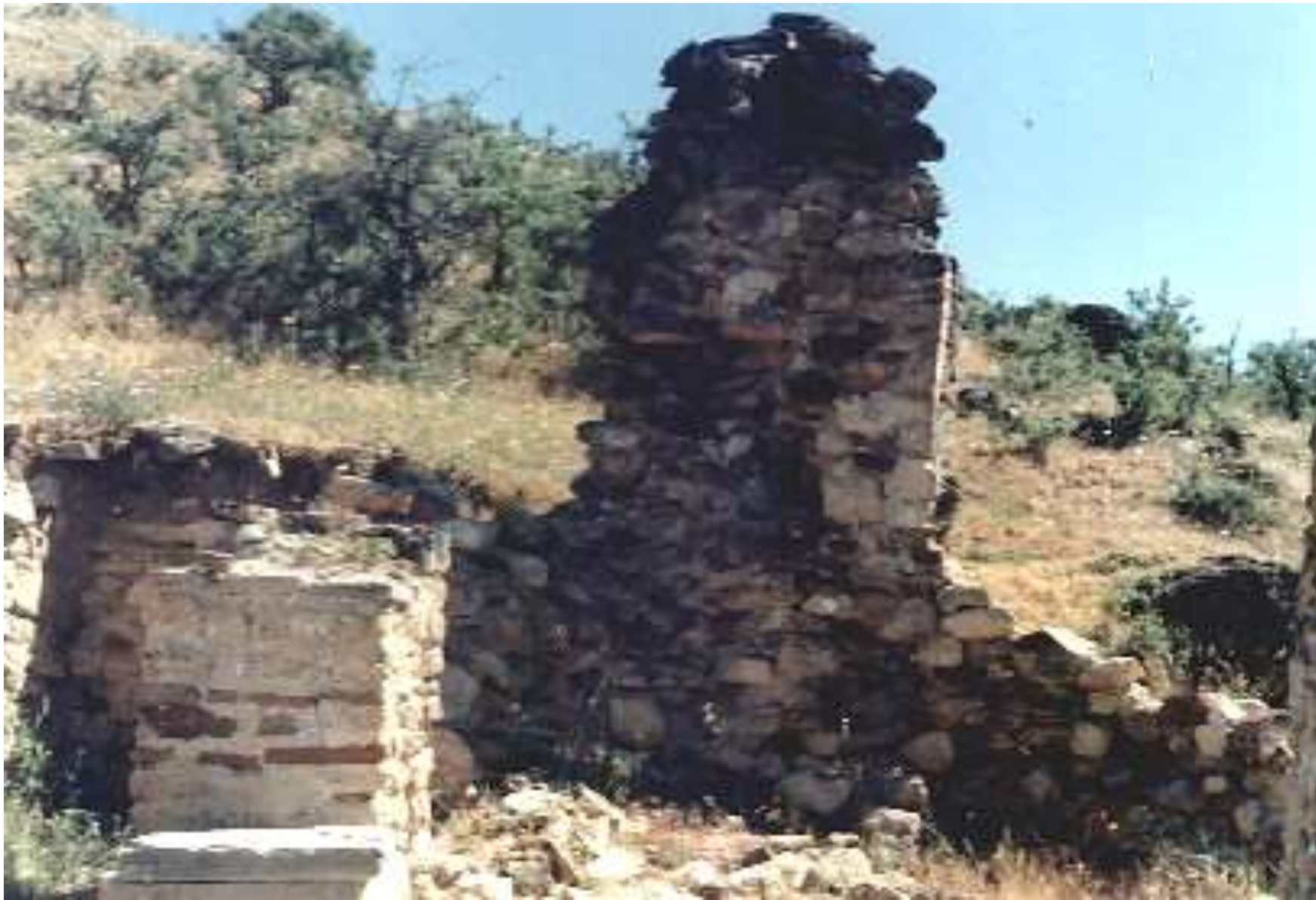
Η κόγχη του ιερού. Διακρίνεται το ίχνος από το κατεστραμμένο παράθυρο και ο αρμός ανάμεσα στο ιερό και το βόρειο τοίχο.
