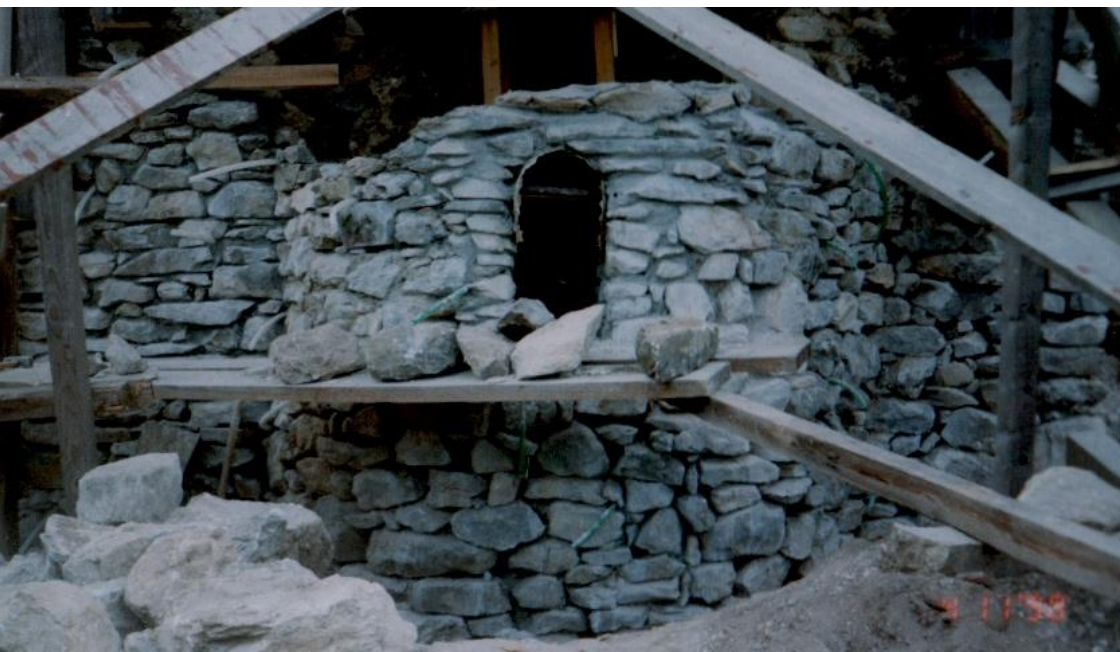
Καθολικό. Αρμολογήματα - ανακτήσεις
