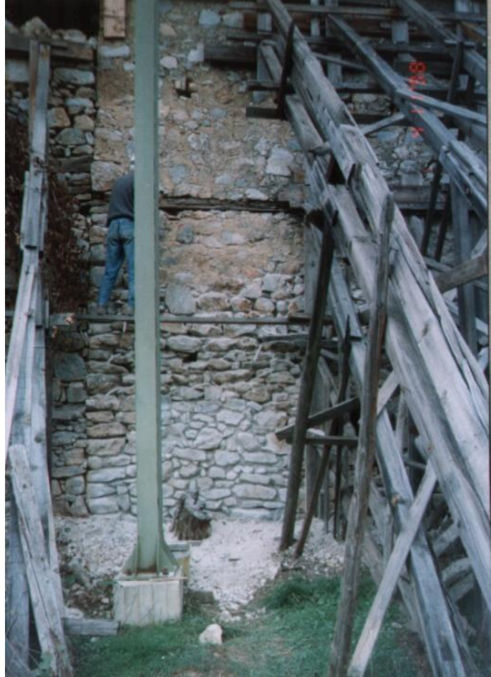
Αρμολογήματα – ανακτήσεις, αντικατάσταση σαθρών ξυλοδεσιών
