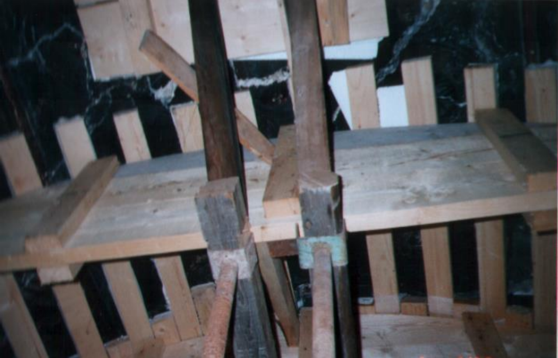
Υποστύλωση του θόλου
