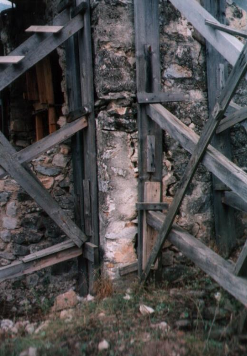
Κατασκευή στεγάστρου, περιδέσεις, Βελτίωση αντιστηρίξεων
