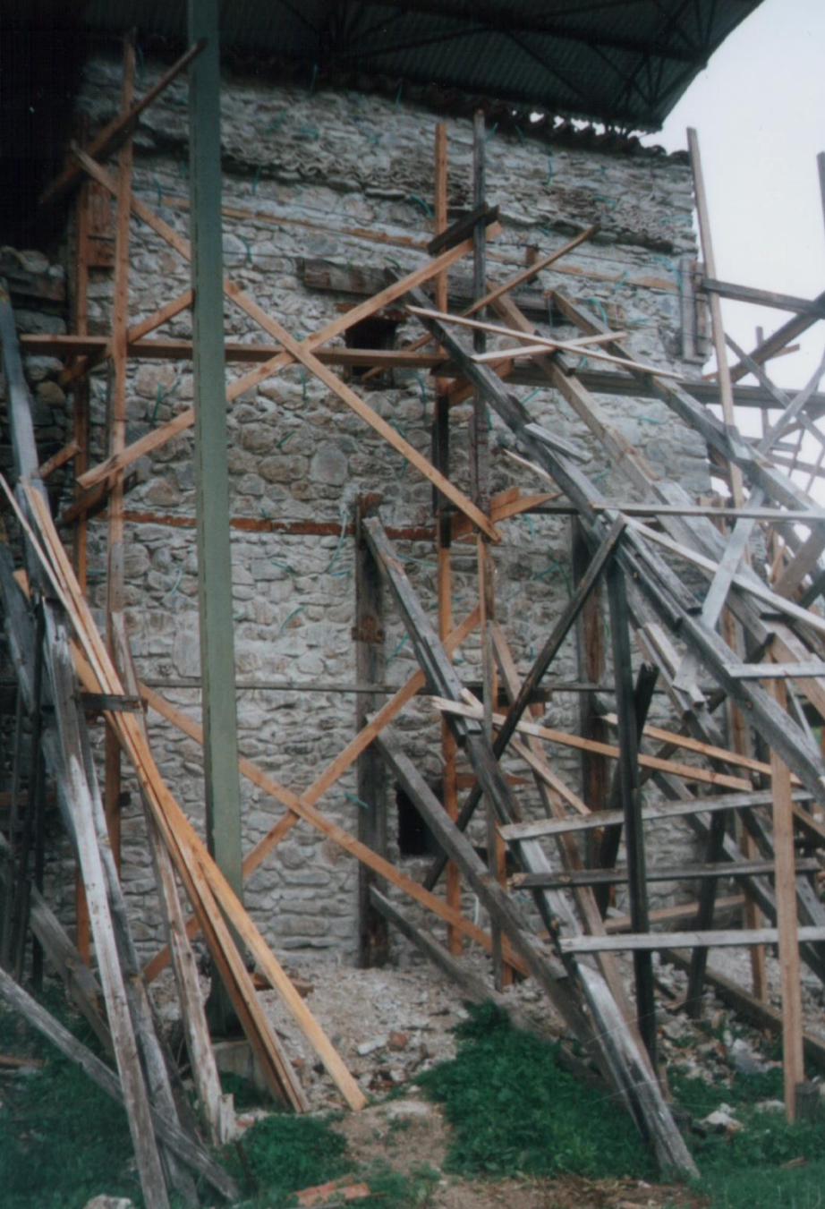
Αρμολογήματα – ανακτήσεις, αντικατάσταση σαθρών ξυλοδεσιών
