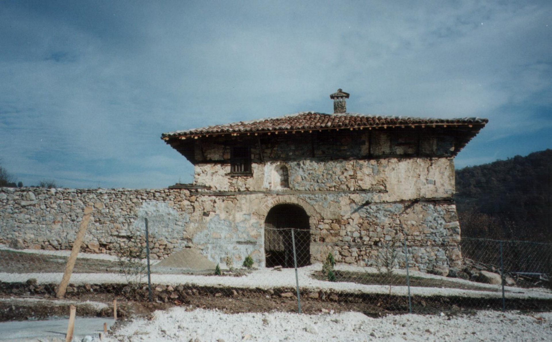
Είσοδος στη μονή Προσωρινή στερέωση τοιχοποιιών - Περίφραξη
