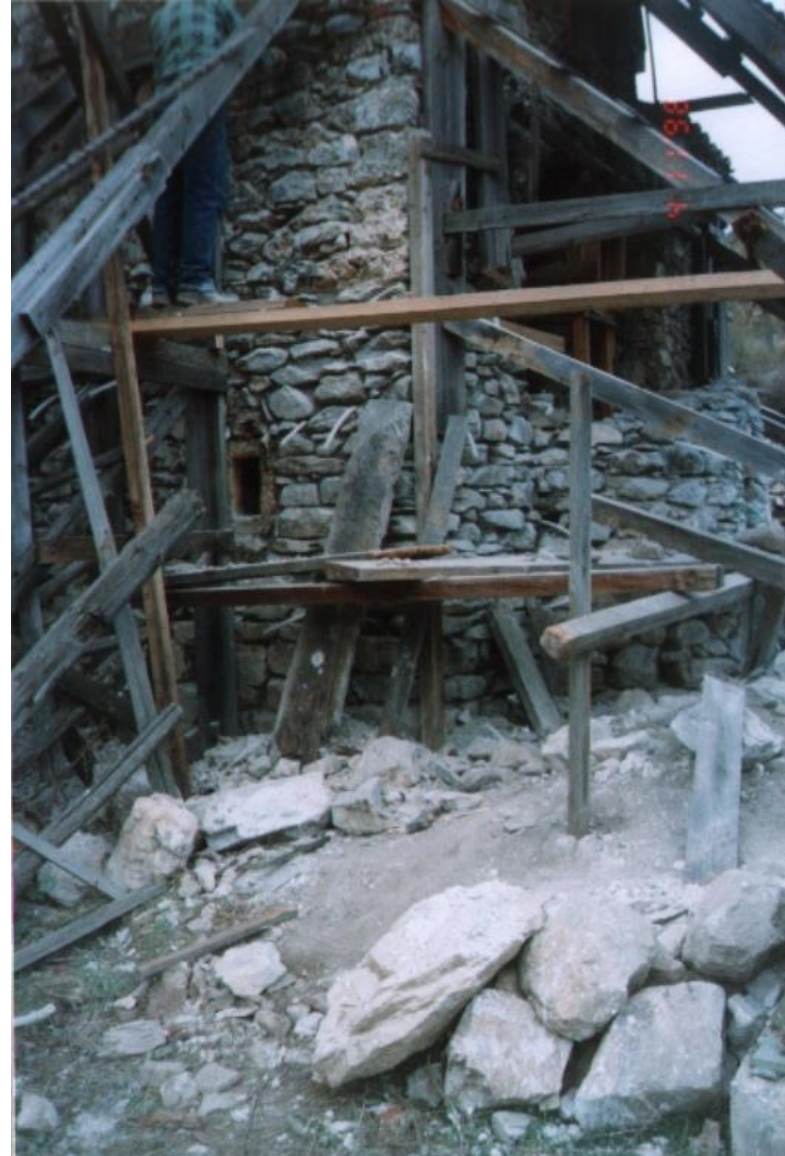
Καθολικό. Αρμολογήματα - ανακτήσεις
