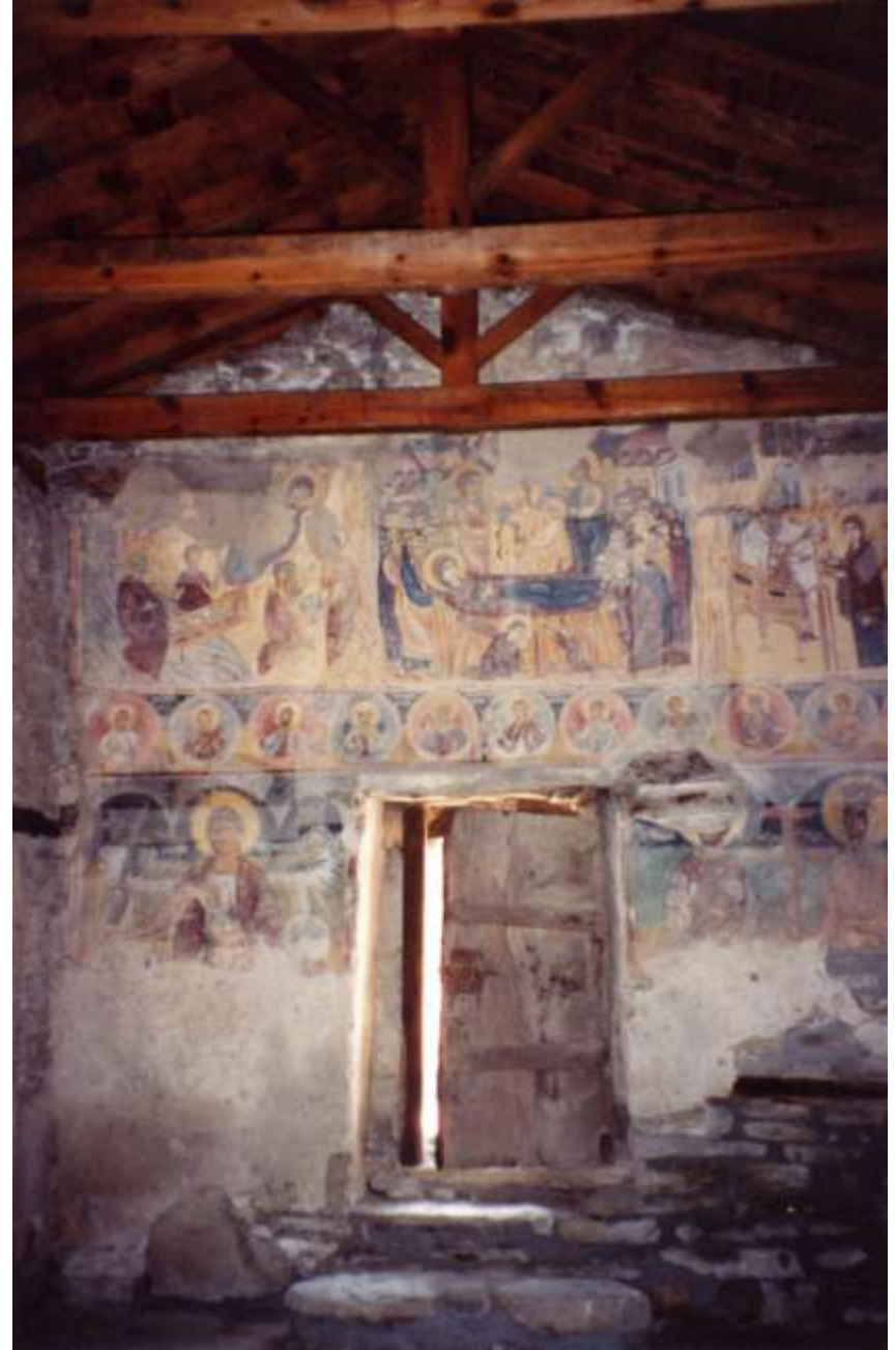
Ο δυτικός τοίχος εσωτερικά, μετά τις στερεωτικές εργασίες
