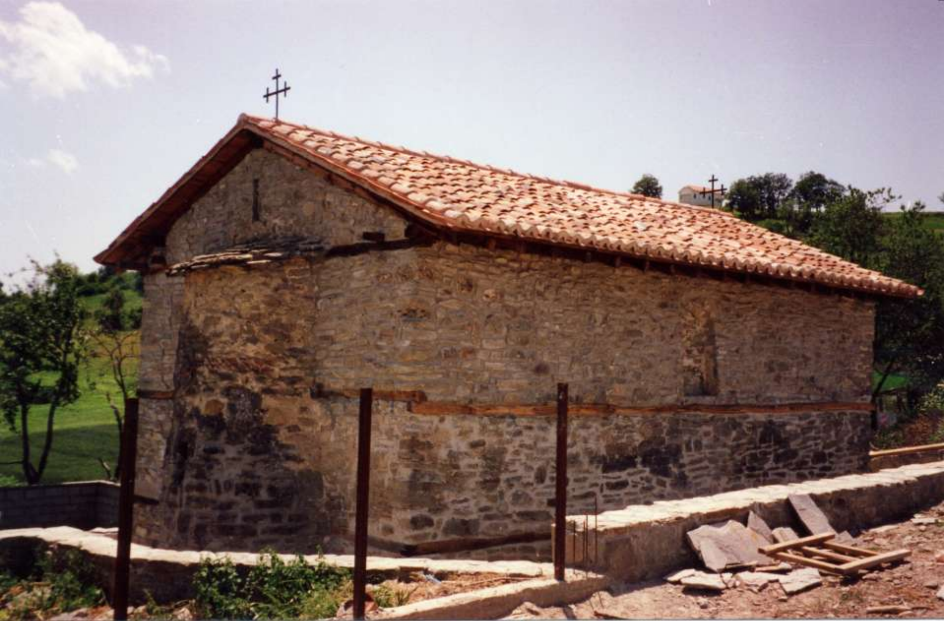
Βόρεια και ανατολική όψη, μετά τις στερεωτικές εργασίες
