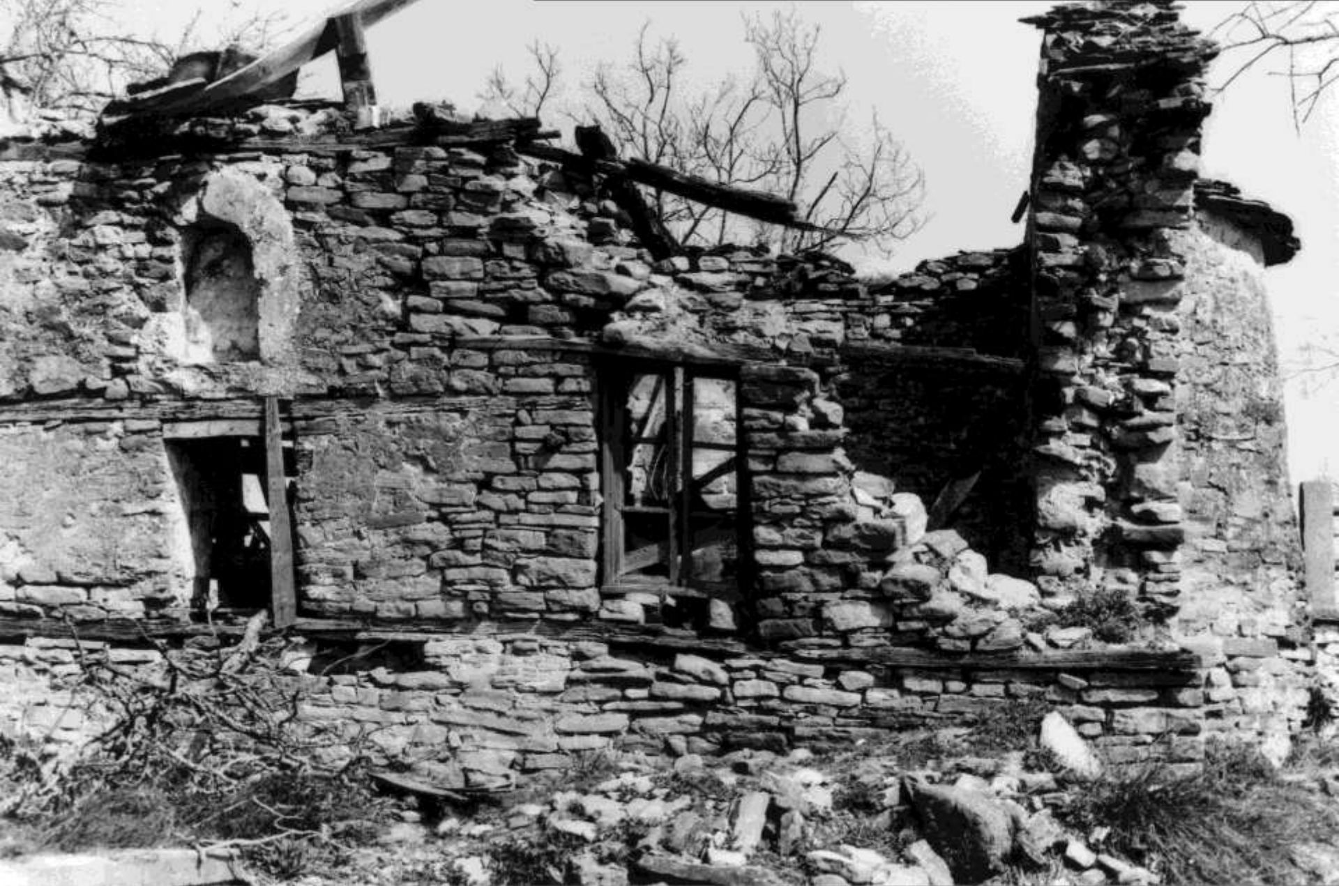
Νότια όψη, περί το 1970. Ήδη τμήμα της ΝΑ γωνίας έχει καταρρεύσει. Διακρίνεται μεταγενέστερο παράθυρο που διανοίχθηκε, καθώς και η διαφορετική δομή του ανατολικού τμήματος του νότιο τοίχου που δηλώνει ότι ανακατασκευάστηκε στο παρελθόν.
