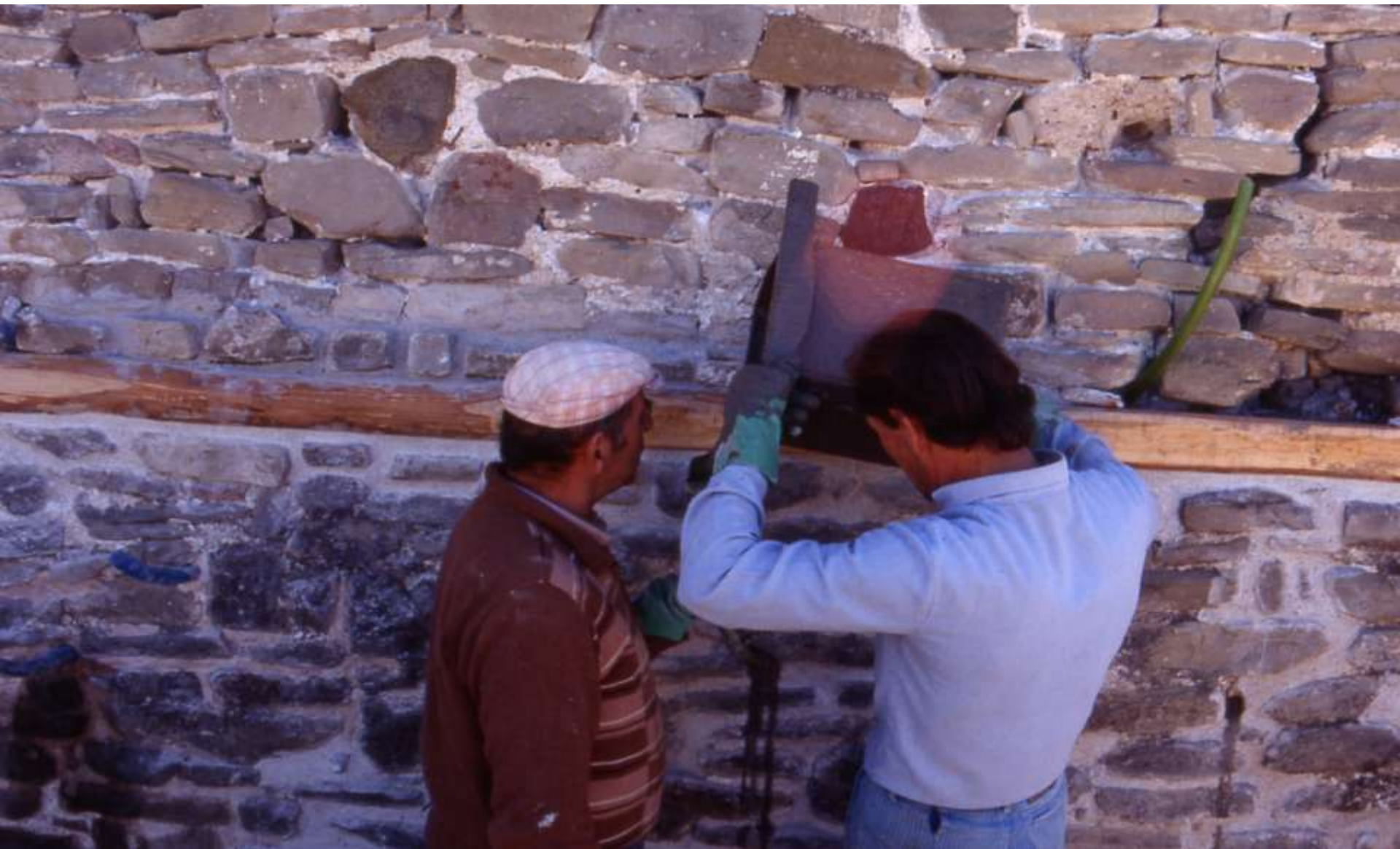
Ενέματα συγκόλλησης ρωγμών και πλήρωσης κενών στο εσωτερικό των τοιχοποιιών
