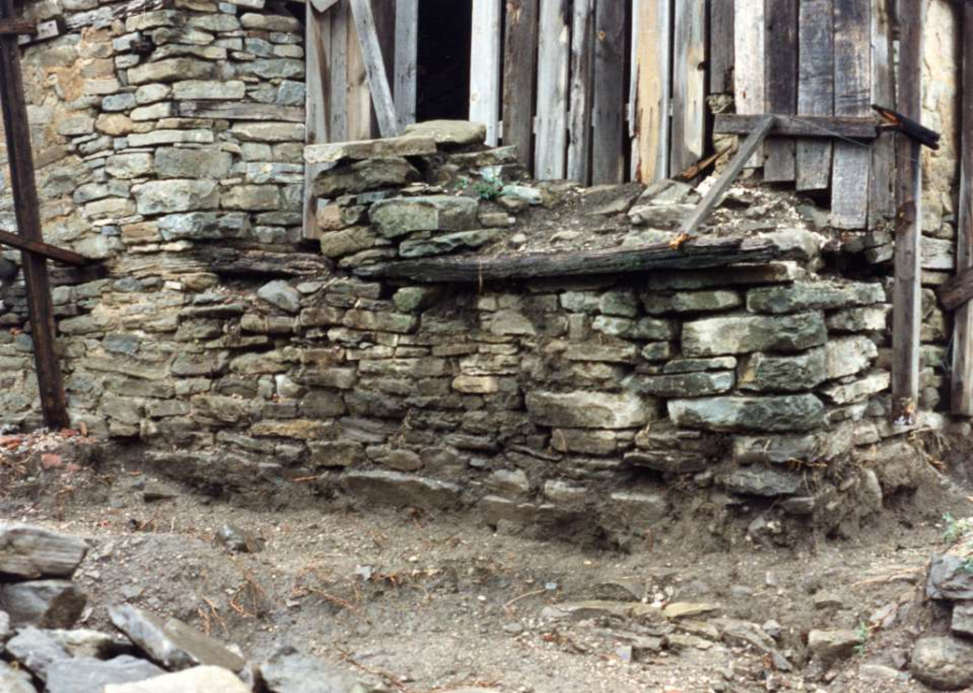
Έρευνα θεμελίωσης με διερευνητικές τομές
