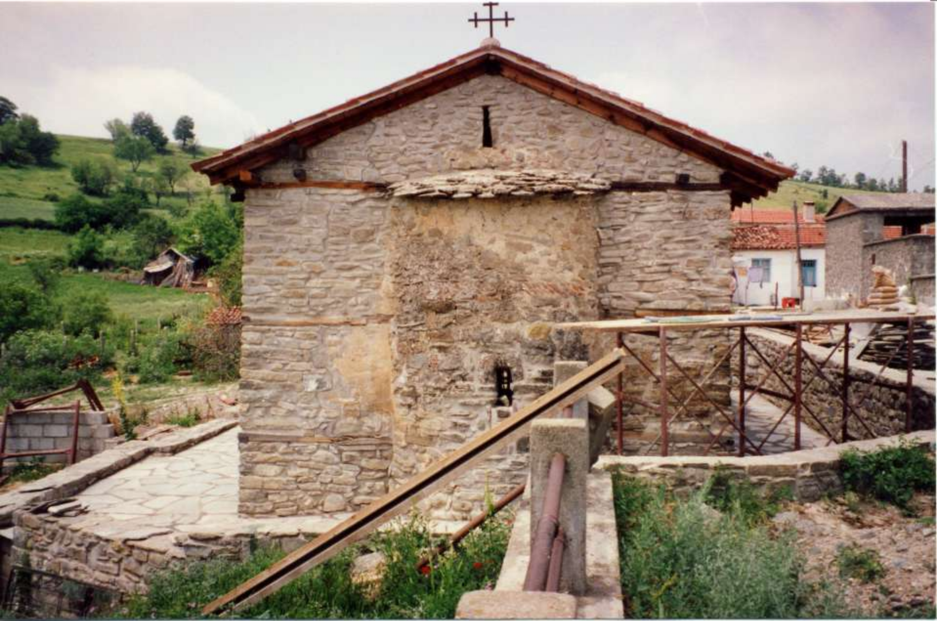
Ανατολική όψη, μετά τις εργασίες
