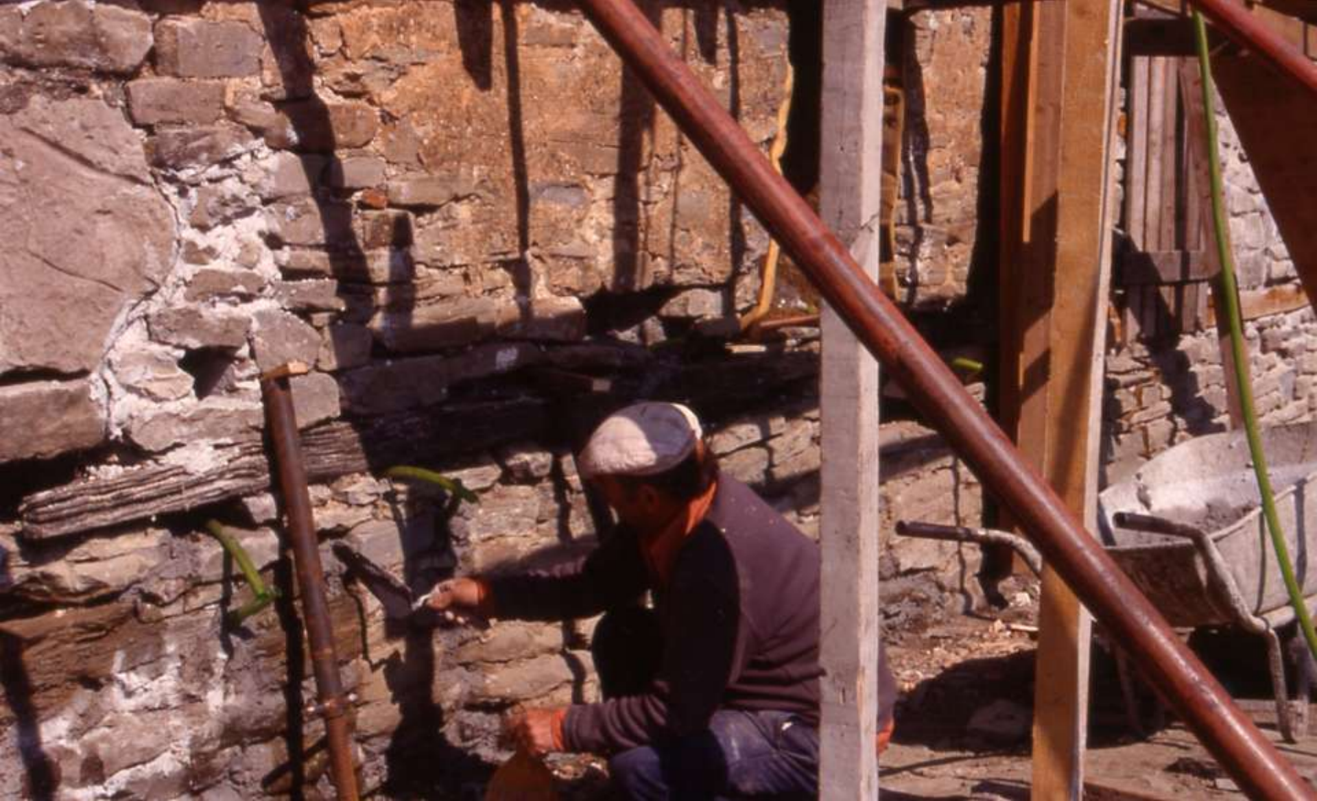
Αρμολογήματα σε βάθος Το αρχικό επίχρισμα διατηρήθηκε, ως υλική μαρτυρία της κατασκευής.
