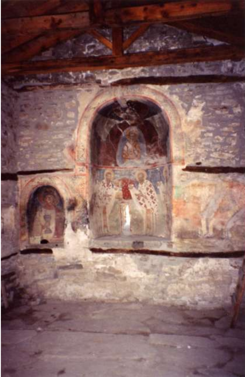
Ο ανατολικός τοίχος εσωτερικά, μετά τις στερεωτικές εργασίες
