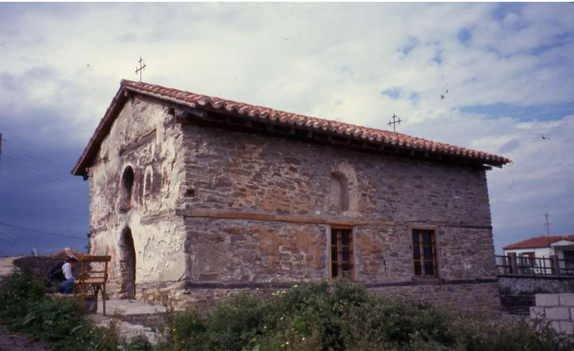
Νότια και δυτική όψη, μετά τις στερεωτικές εργασίες
