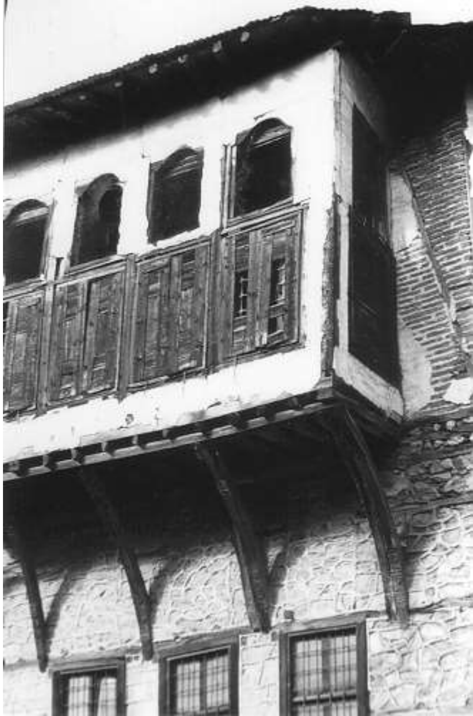
Νότια όψη Το μοναδικό σωζόμενο αρχικό σαχνισί Κάτω από αυτό διακρίνονται μεταγενέστερα φραγμένοι φεγγίτες
