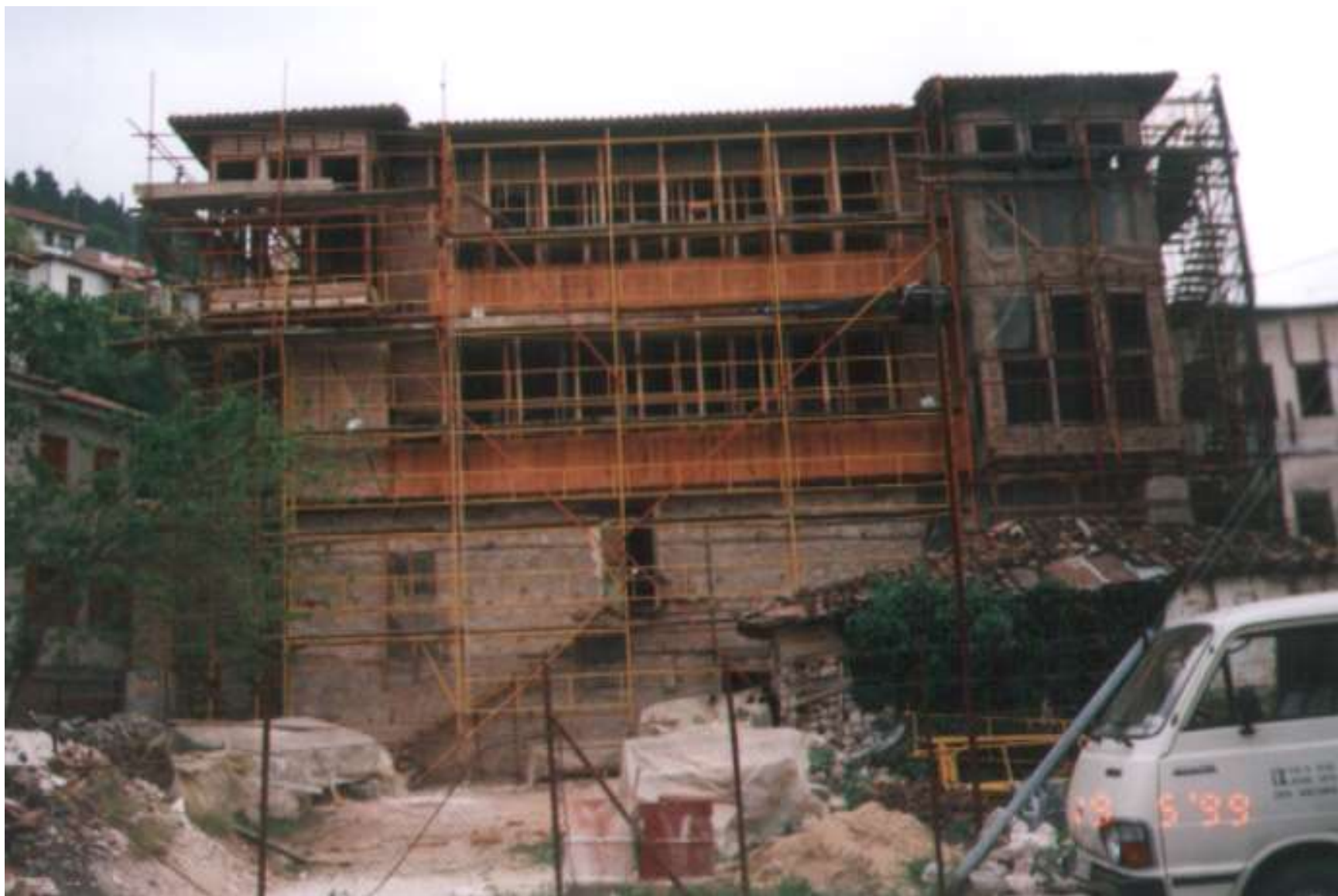
Ανακατασκευή σαχνισί και ηλιακών στη βόρεια όψη
