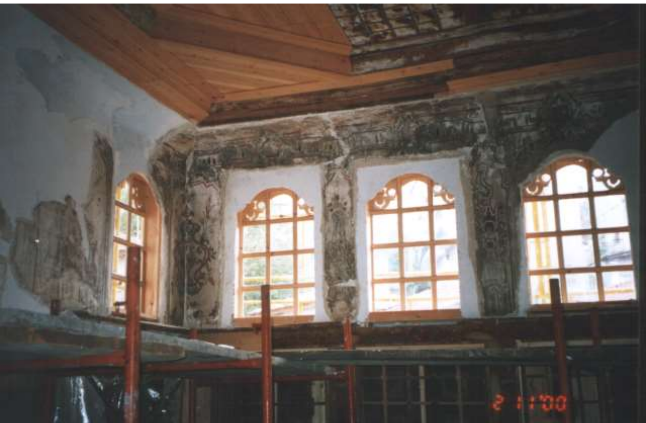
2 ος όροφος ΝΔ οντάς. Αποτοίχιση, συντήρηση και επανατοποθέτηση τοιχογραφιών
