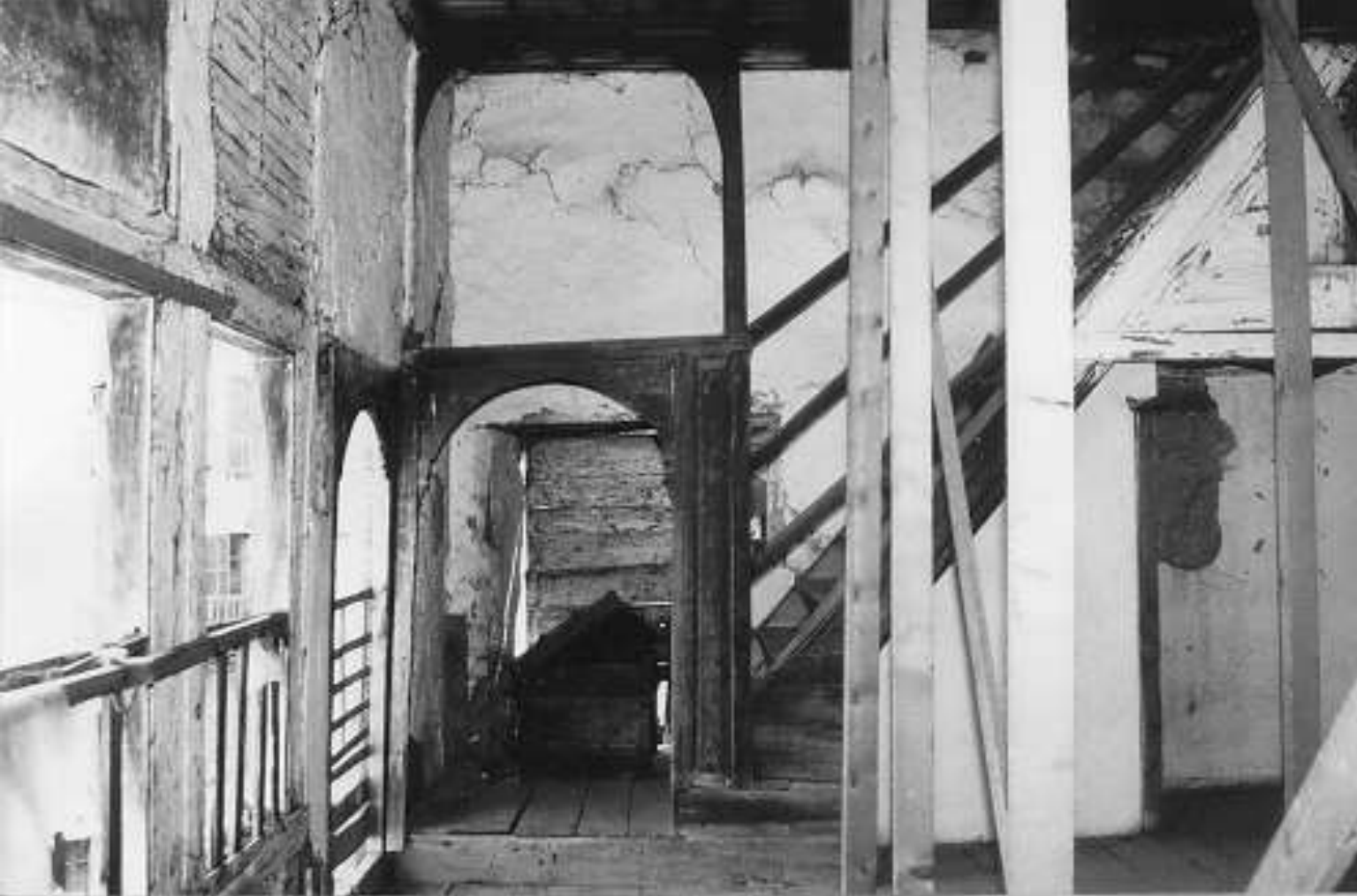
Καθαρισμοί, υποστυλώσεις, περισυλλογή οικοδομικού υλικού
