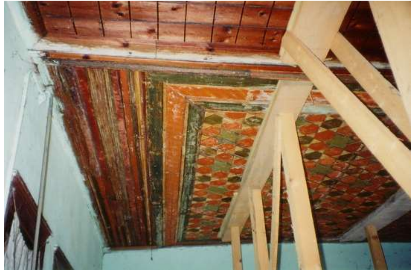
Προσεκτική υποστήλωση οροφών με διάκοσμο
