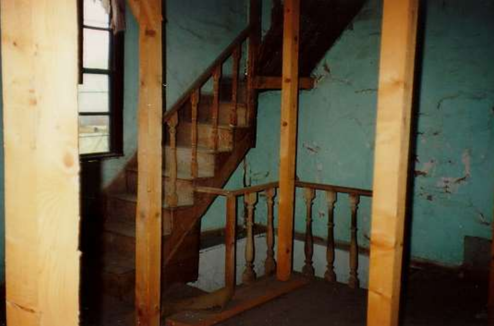
Μεσοπάτωμα στο δυτικό τμήμα του κτηρίου
