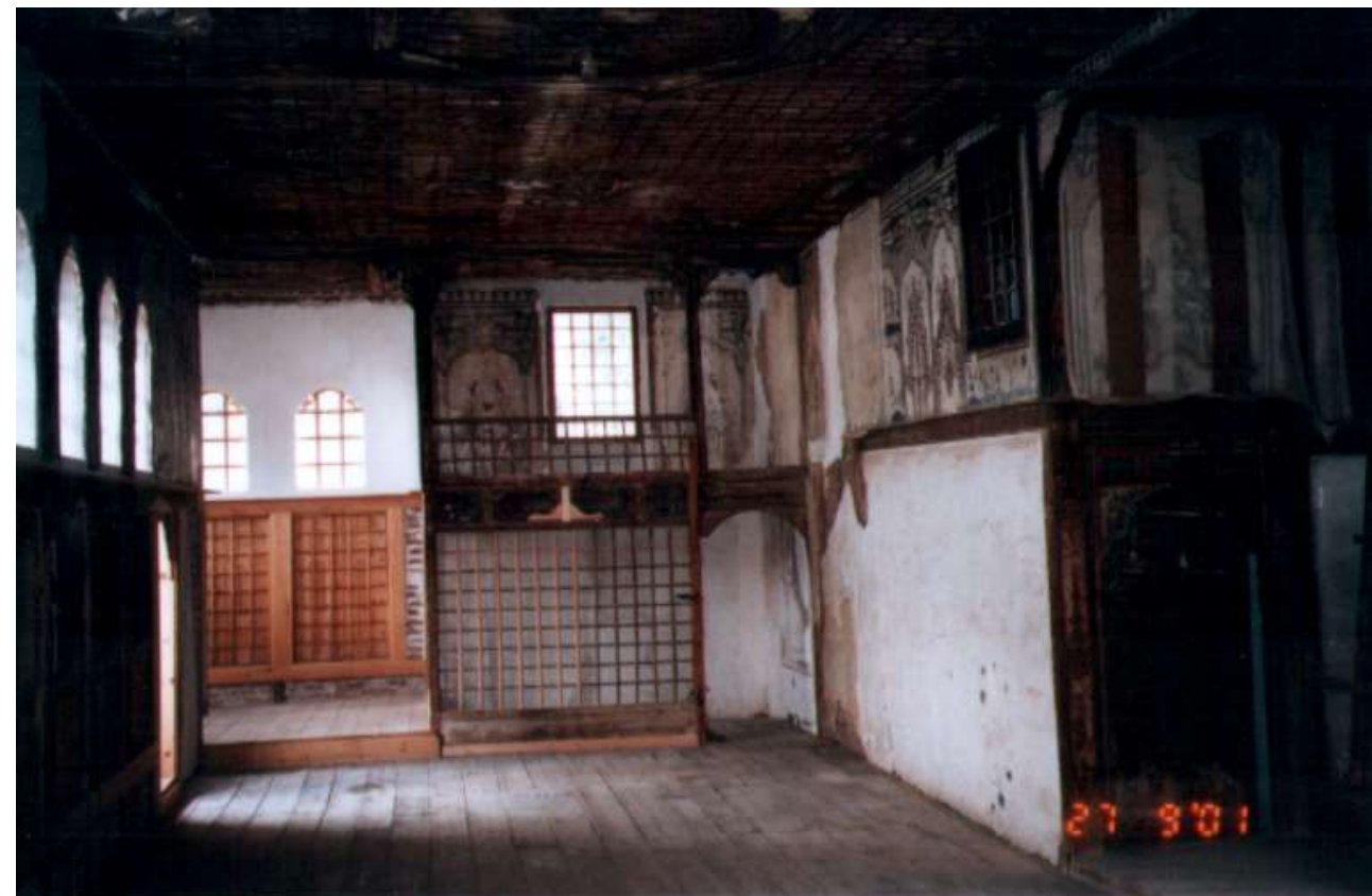
2 ος όροφος. Ο δοξάτος. Αποτοίχιση, συντήρηση και επανατοποθέτηση τοιχογραφιών. Ανακατασκευή κουφωμάτων
