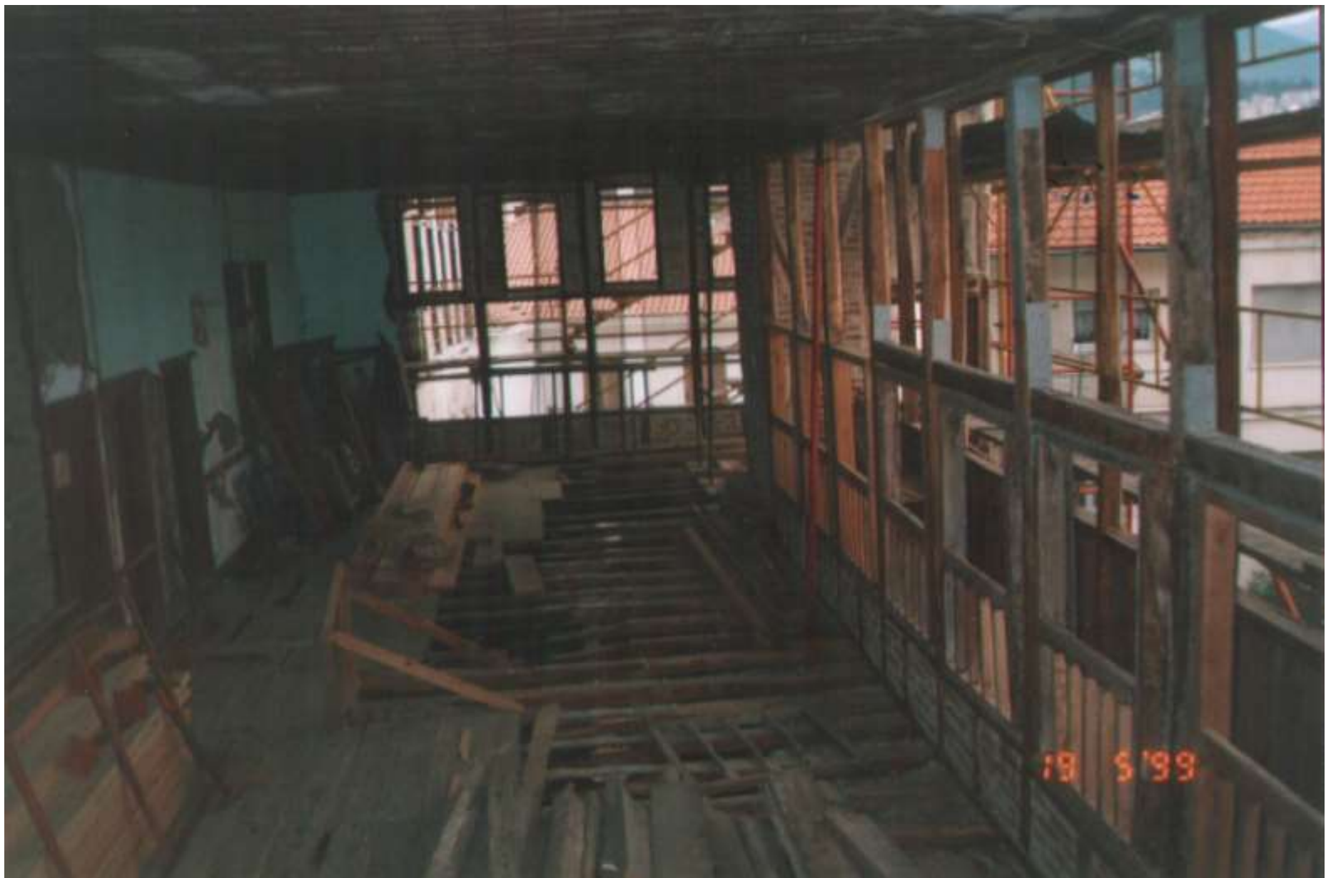
Επισκευή και μερική ανακατασκευή ξυλοκατασκευών βόρειας όψης
