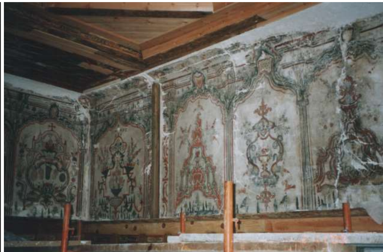
2 ος όροφος ΝΔ οντάς. Αποτοίχιση, συντήρηση και επανατοποθέτηση τοιχογραφιών
