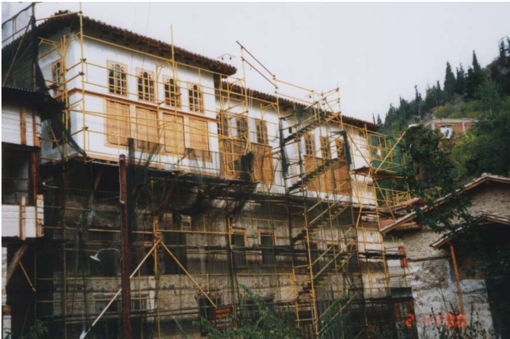
Εργασίες στη νότια όψη
