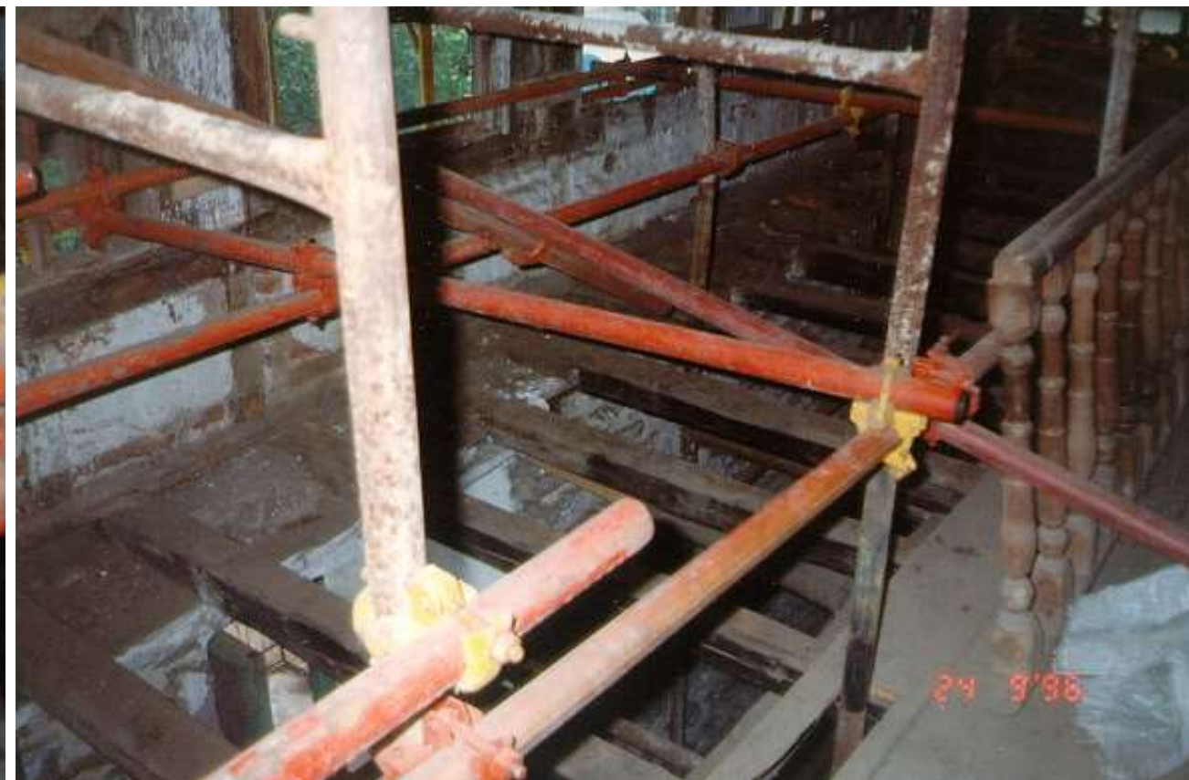
Λεπτομέρεια από την έδραση των σκελετού του δαπέδου και των ξυλόπηκτων τοίχων στη λιθοδομή
