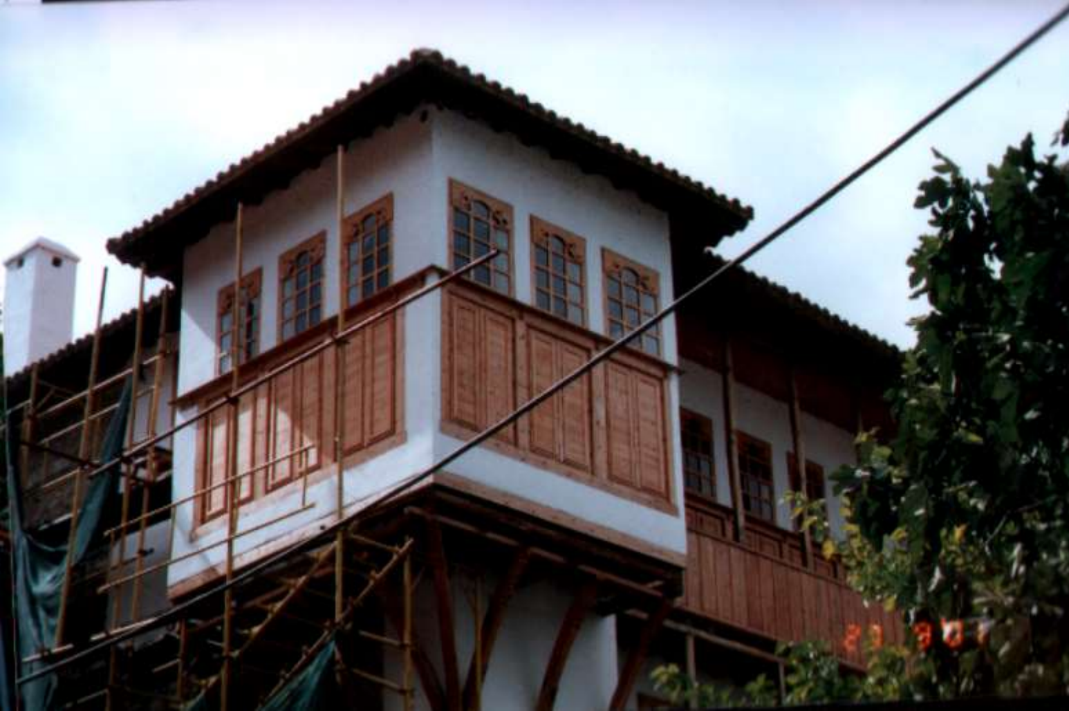
Ανακατασκευή ΒΑ σαχνισί
