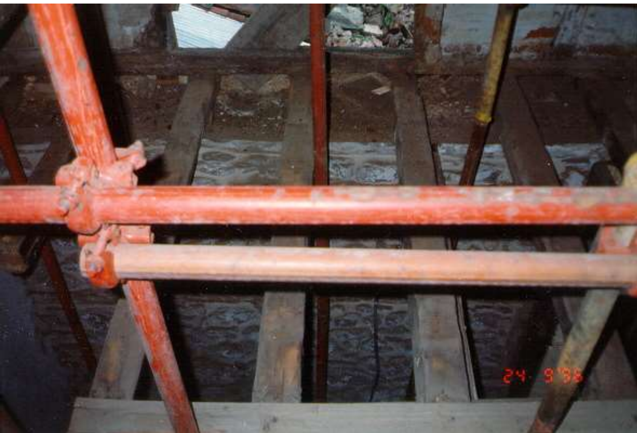
Λεπτομέρεια από την έδραση των σκελετού του δαπέδου και των ξυλόπηκτων τοίχων στη λιθοδομή
