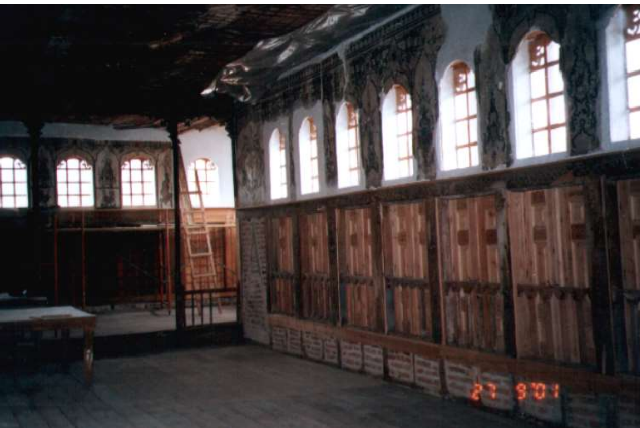
2 ος όροφος. Ο δοξάτος. Αποτοίχιση, συντήρηση και επανατοποθέτηση τοιχογραφιών. Ανακατασκευή κουφωμάτων
