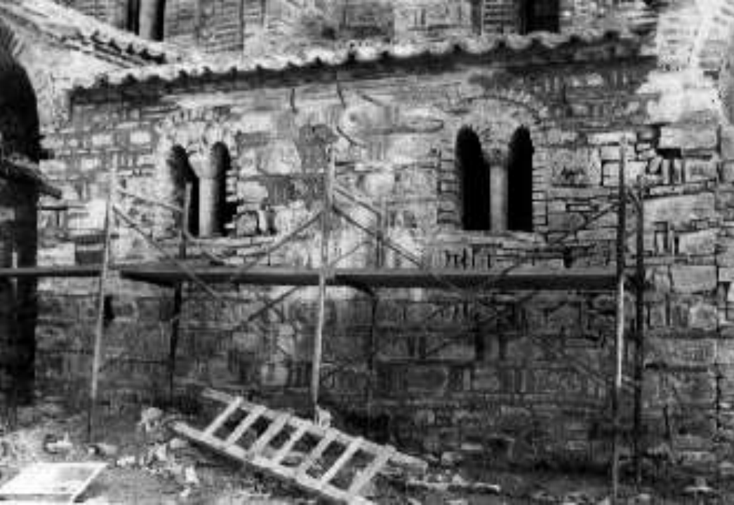
Βόρεια όψη Καθαρισμοί ρωγμών και σαθρών κονιαμάτων
