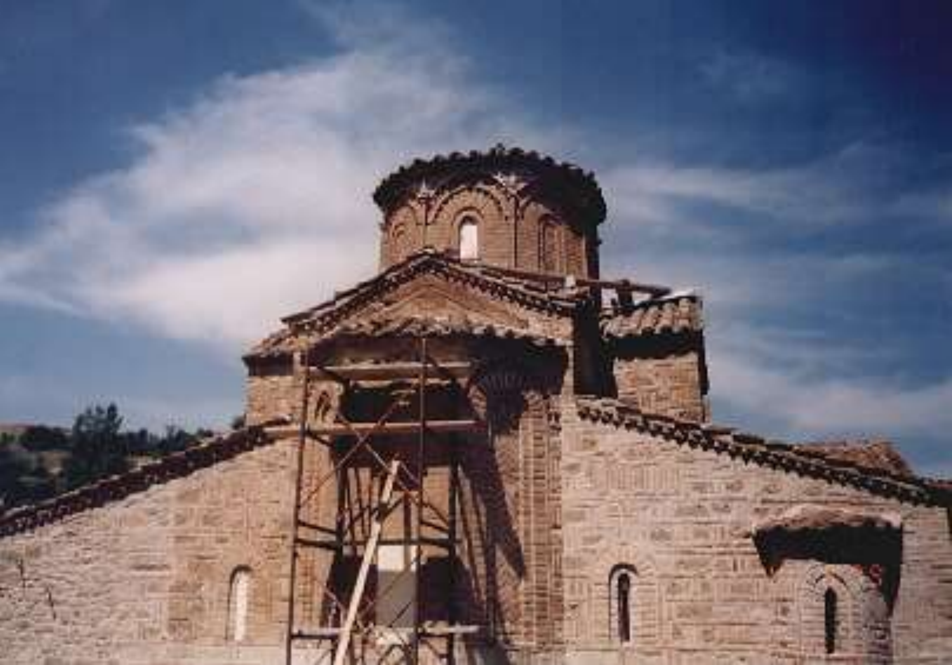
Ανατολική όψη, κατά τη διάρκεια των εργασιών
