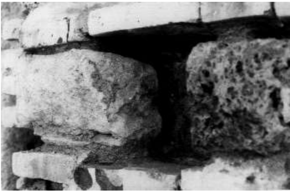
Βόρεια όψη Καθαρισμοί ρωγμών και σαθρών κονιαμάτων
