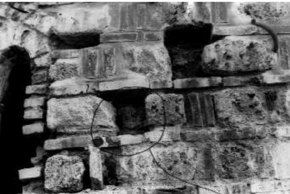
Βόρεια όψη Καθαρισμοί ρωγμών και σαθρών κονιαμάτων
