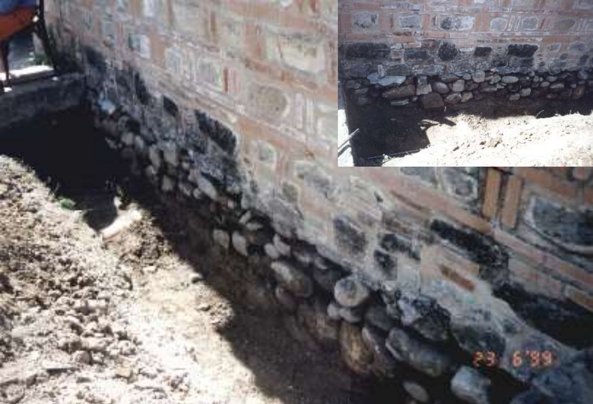
Βόρεια όψη. Έρευνα θεμελίωσης. Διαπιστώθηκε ότι, σε αντίθεση με την ανατολική όψη, η θεμελίωση εδώ είναι αβαθής και πρόχειρη κατασκευή.
