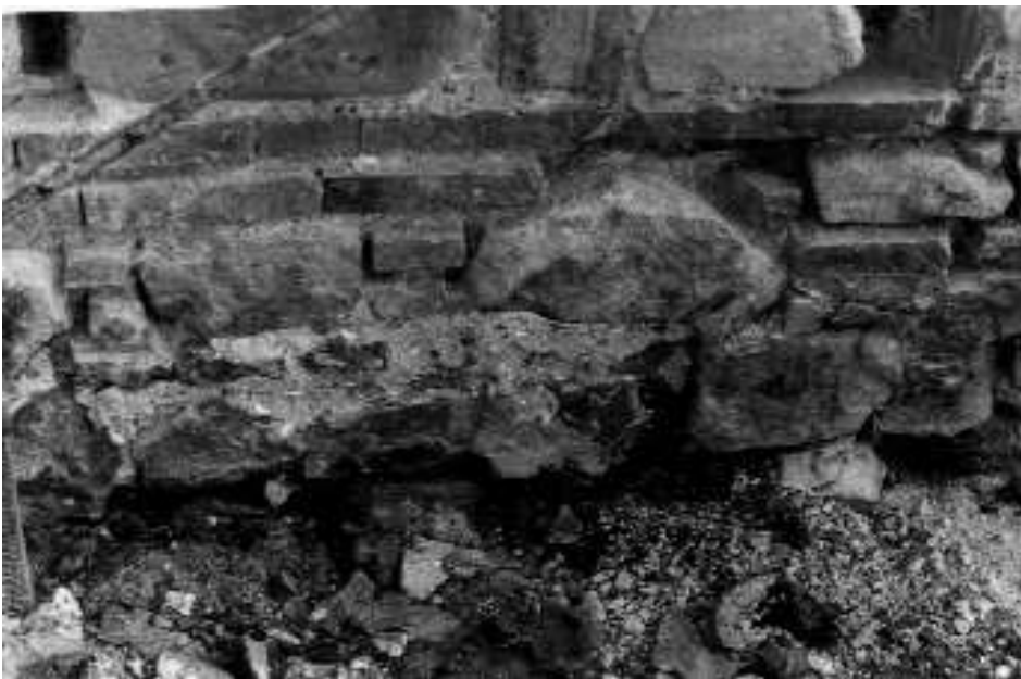
Βόρεια όψη Καθαρισμοί ρωγμών και σαθρών κονιαμάτων
