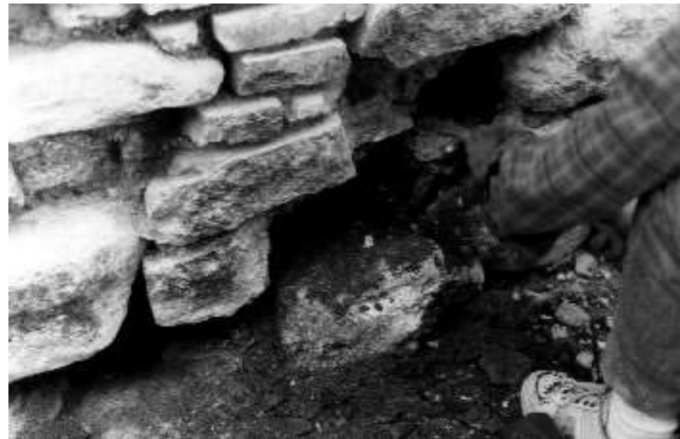
Βόρεια όψη Καθαρισμοί ρωγμών και σαθρών κονιαμάτων
