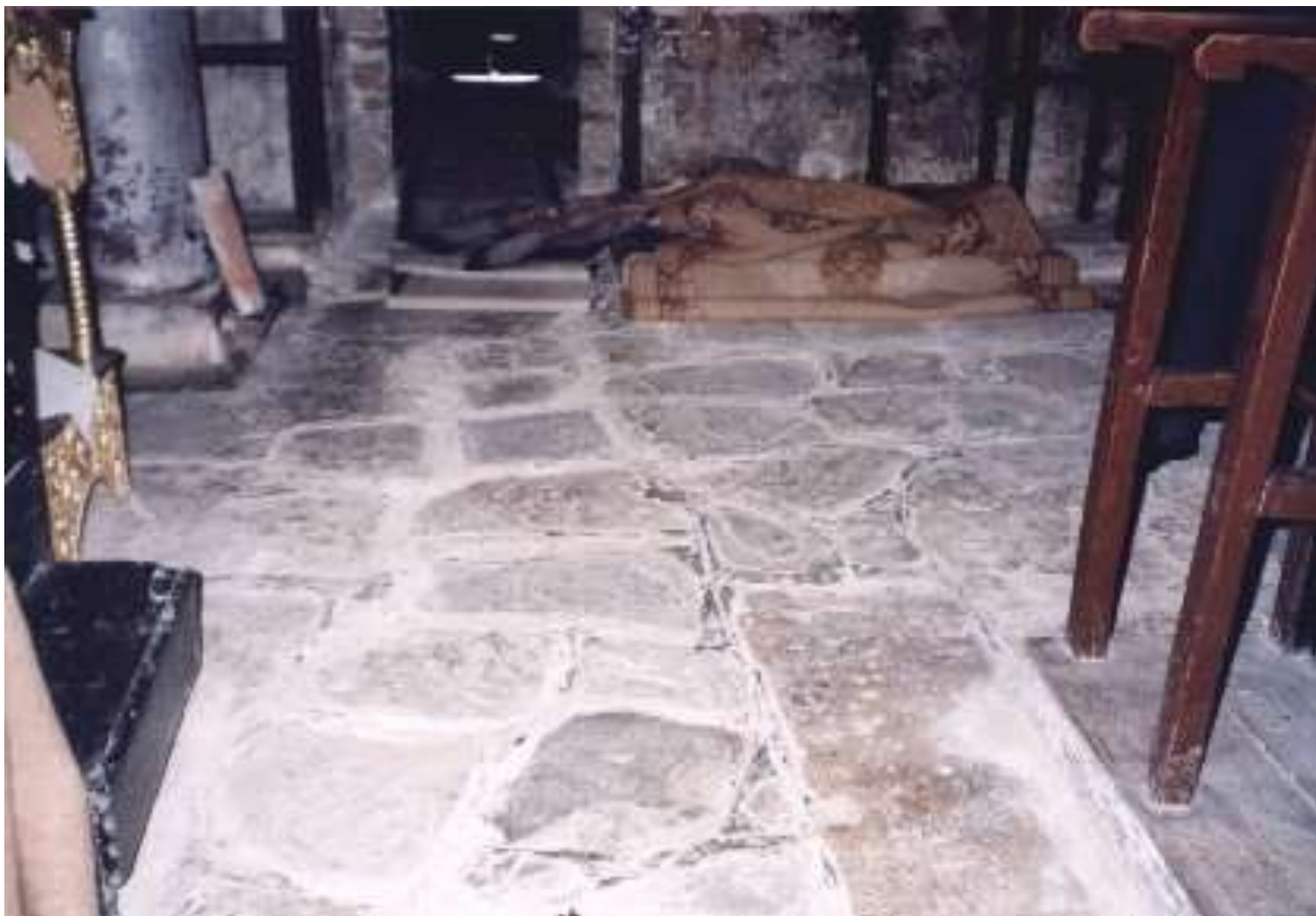
Το λίθινο δάπεδο, μετά τις εργασίες
