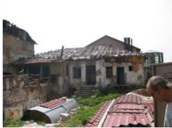
Εικ. 6 Κατοικία επί του πύργου. Βόρεια όψη
