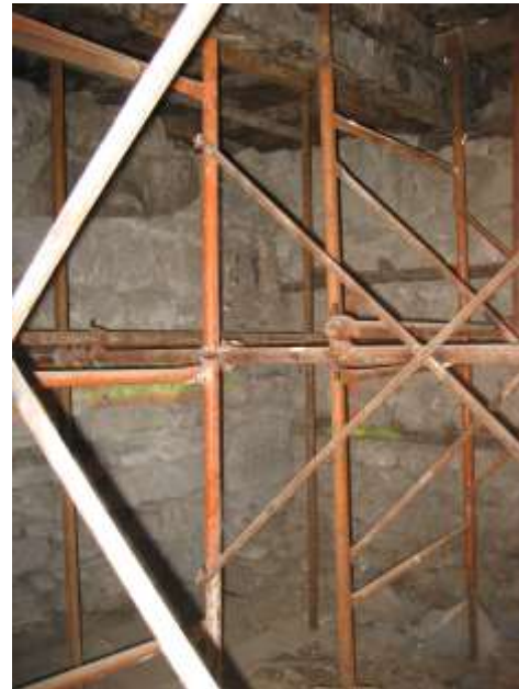
Εικ. 14 Η γωνία που συναντά ο διάμεσος τοίχος (αριστερά) το νότιο. Διακρίνονται οι ξυλοδεσιές που σταματούν στη γωνία. Η παρειά αυτή του διάμεσου τοίχου συνεχίζεται μέχρι την εξωτερική όψη.
