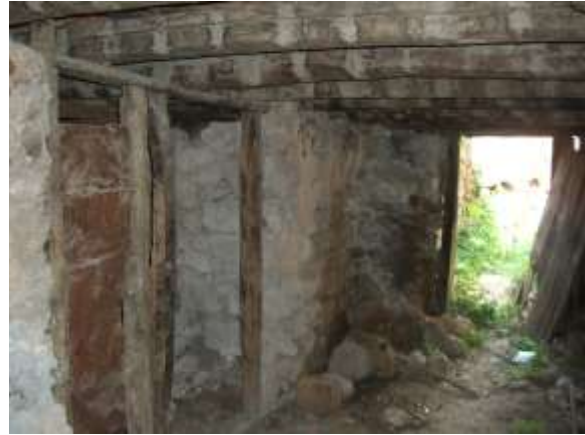
Εικ. 16 Το πρόχειρα διαμορφωμένο άνοιγμα (αριστερά), για την προσπέλαση στο μεταγενέστερο δυτικό τμήμα του πύργου.
