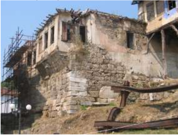
Εικ. 5 Κατοικία επί του πύργου. ΝΑ γωνία
