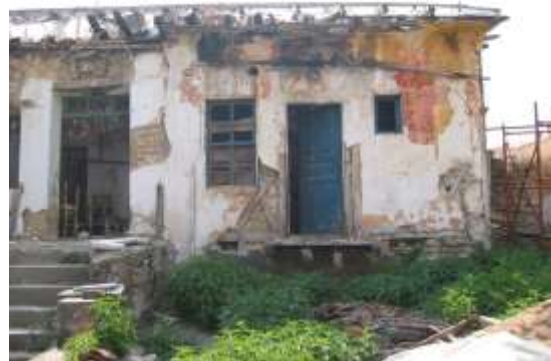
Εικ. 18 Δυτικό τμήμα βόρειας όψης. Η πόρτα δεξιά διανοίχθηκε στη θέση παραθύρου και το οι διαστάσεις στο δεξί παράθυρο περιορίστηκαν.
