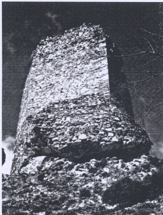
1. Κάστρο Σερβίων. Γωνιακός πύργος στην Ακρόπολη.
