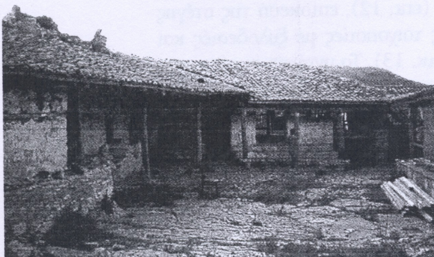
10. Μονή Ζάβορδας. Μετά τις εργασίες αποκατάστασης
