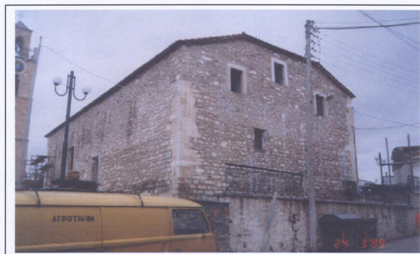
Τίμιος Πρόδρομος Λευκοπηγής Ν. Κοζάνης. Μετά το σεισμό και μετά τις εργασίες αποκατάστασης του κελύφους
