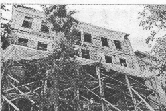
10. Αρχοντικό Μπόζογλου (Κέντρο Τουριστικής Προβολής), κατά τη διάρκεια των εργασιών αποκατάστασης. (φωτο. Κ. Ανδρεάδου).
