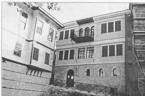
7. Αρχοντικό Τσαρτσάνη (Όλγανος), μετά τις εργασίες αποκατάστασης.
