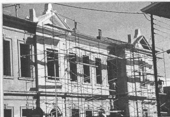
14. Γυμνάσιο Ρακτιβάν (Δημαρχείο), κατά τη διάρκεια των εργασιών.
