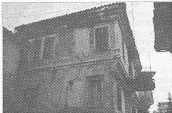
3. Αρχοντικό Τσαρτσάνη (Όθλιανος), πριν από τις εργασίες αποκατάστασης.
