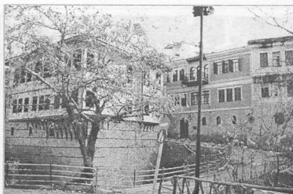
6. Αρχοντικό Τσαρτσάνη (Όλγανος), στο κέντρο και κτίριο Μπέκα αριστερά, μετά τις εργασίες αποκατάστασης. Δεξιά το κτίριο Αναστασίου.
