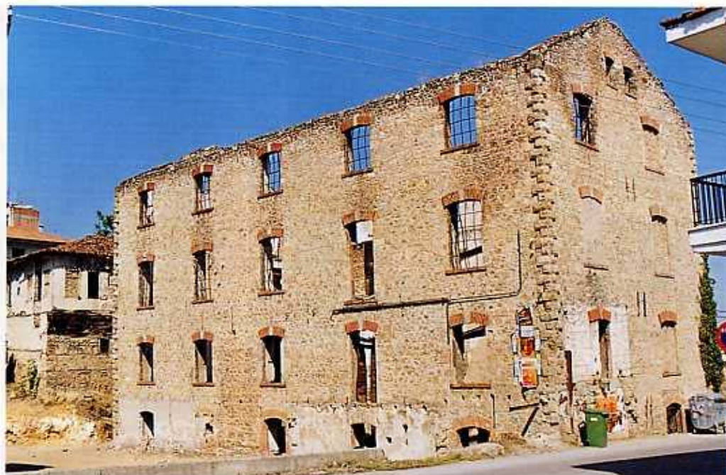
Γενική άποψη του υδρόμυλου πριν την αποκατάσταση.
