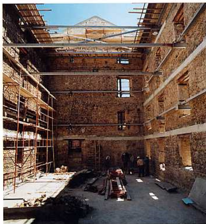
Εσωτερικό του υδρόμυλου κατά τη φάση εργασιών στερέωσης.
