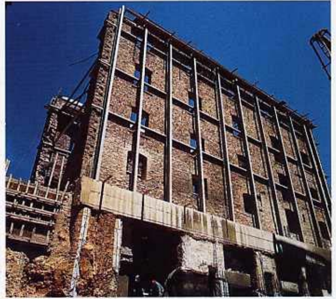
Στήριξη των όψεων κατά την κατασκευή με μεταλλικό πλαίσιο.
