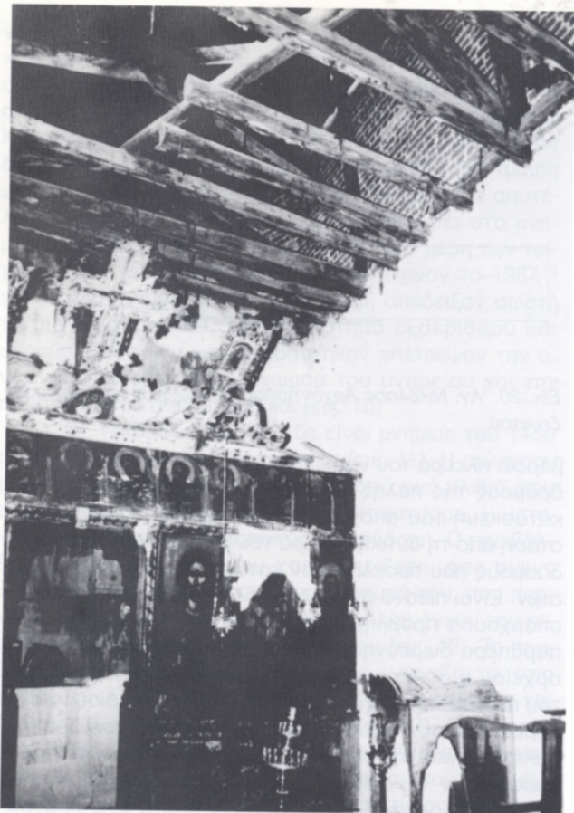
Εικ. 21. 'Αγ. Νικόλαος Καραβιδιά. Τα ζευκτά της στέγης πατούν στον τοίχο της οικοδομής στη θέση που ήταν αρχικά ο νότιος τοίχος του ναού.
