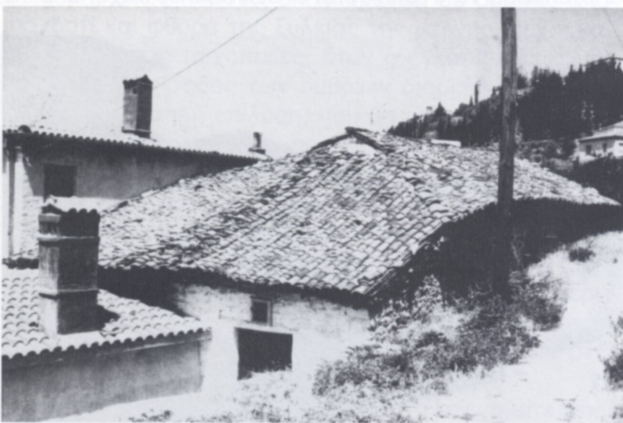
Εικ. 17. 'Αγ. Νικόλαος του Κυρίτη. Κτήρια σε επαφή με τη βόρεια και δυτική πλευρά του.
