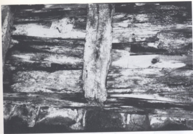
Εικ. 7. 'Αγ. Αντρέας του Ρουσούλη. Αποσάθρωση της ξυλείας στην αστρέχα της στέγης, από την έκθεσή της στις καιρικές συνθήκες.
