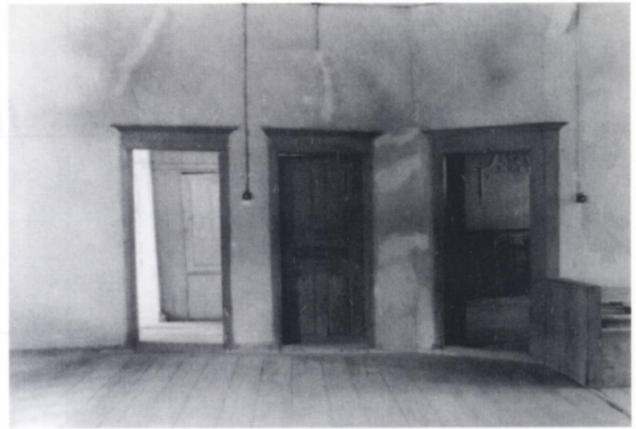
34. Αρχοντικό Σκούταρη. Παραμορφώσεις δαπέδων και κουφωμάτων.
