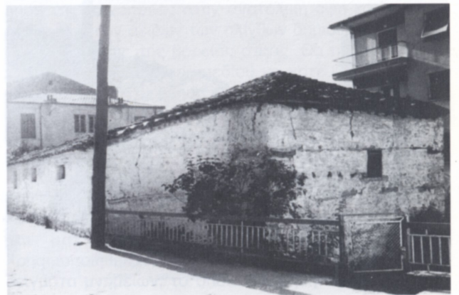
Εικ. 16. Ταξiάρχης ενορίας Άγ. Λουκά. Ρωγμές στις απολήξεις των περιμετρικών τοιχοποιιών.
