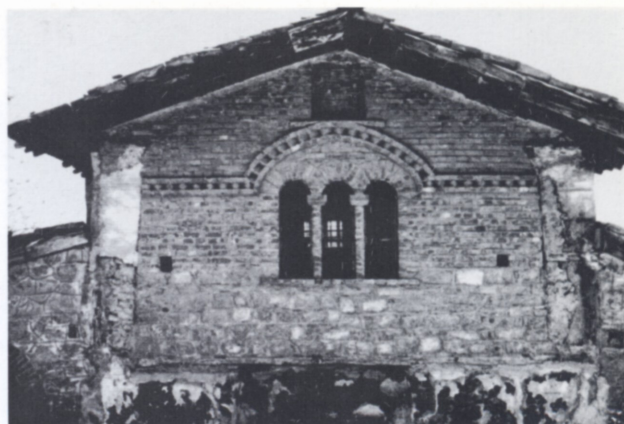
Εικ. 23. 'Αγ. Τρείς. Ανακατασκευασμένο τμήμα στη δυτική όψη.
