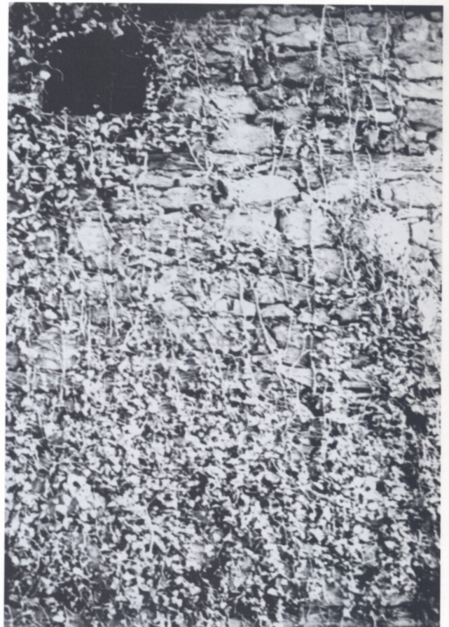
Εικ. 6. Αγ. Ιωάννης ο Πρόδρομος. Τα αναρριχητικά φυτά προκαλέσαν αποσάθρωση σε βάθος του κονιάματος της τοιχοποιίας.
