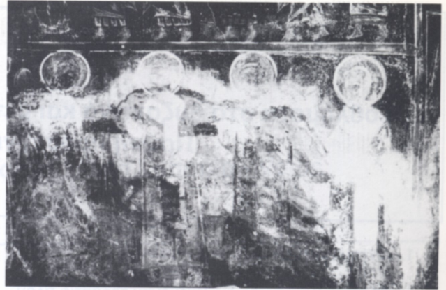
Εικ. 4. Αγ. Νικόλαος του Καρύβη. Άλατα επί των τοιχογραφιών στην κόγχη του ιερού και σε ύψος χαμηλότερο από τη στάθμη του εδάφους.
